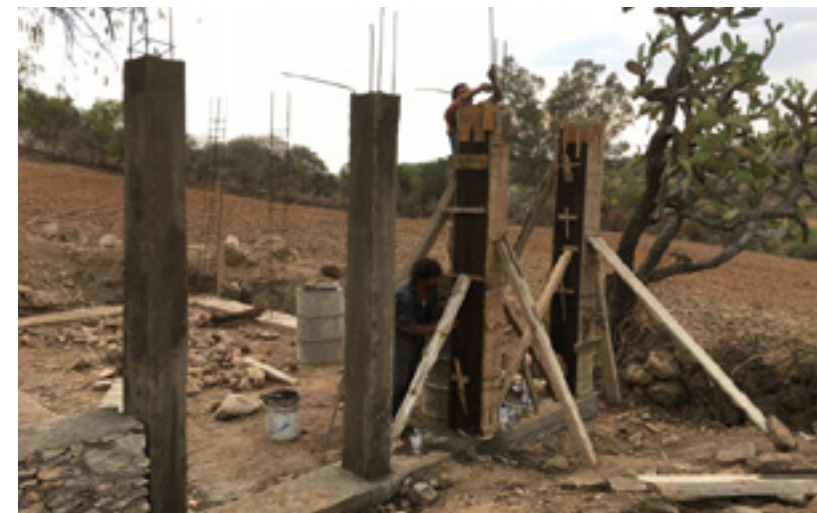
(6.12) Cimbra y colado para marcos de concreto de muros.
