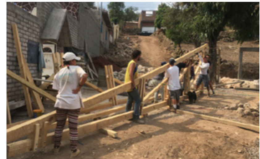
(6.26) Armadura lista para ser montada.
