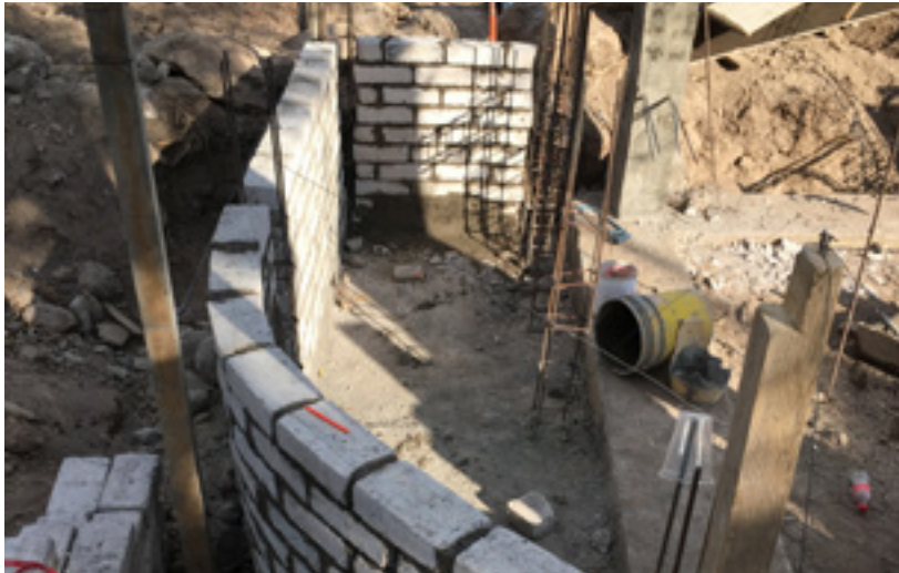
(6.34) Bicicibomba funcionando y llenando la pileta contigua a los lavaderos.
