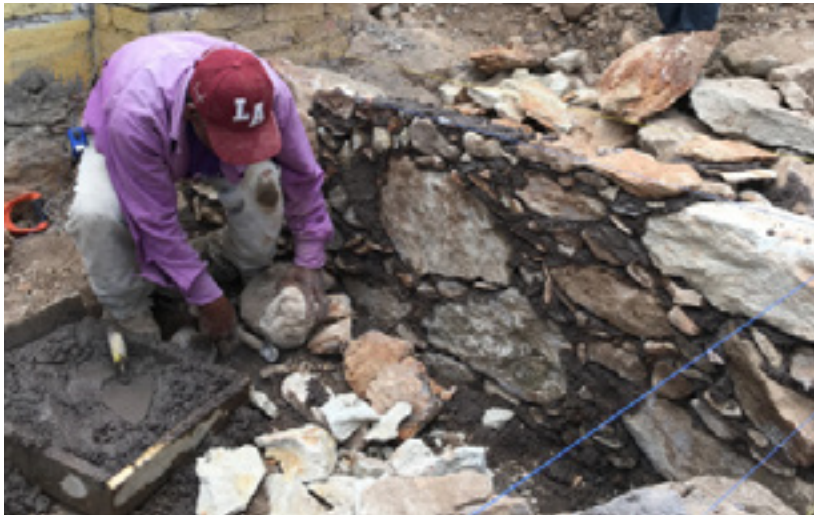
(6.22) Construcción de muros de contención.
