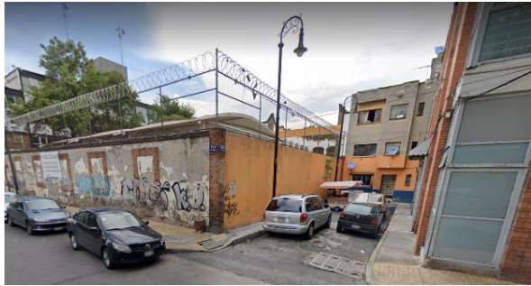
Fotografía 3. Vista del Cjon. Zarco, zona a intervenir en el proyecto. Fotografía propiedad de Google, Año 2019
