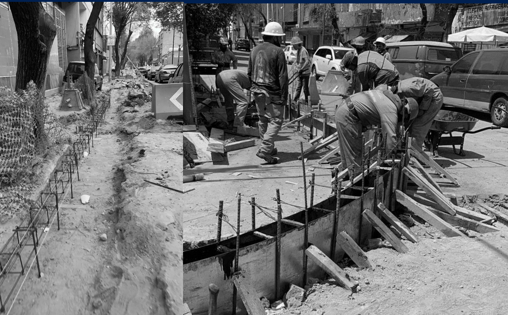
Foto: Trabajos de rehabilitación de la calle Francisco Zarco, Alcaldía Cuauhtémoc en la Ciudad de México, Año 2021, fotografías propiedad de Grupo IndeProyec.
