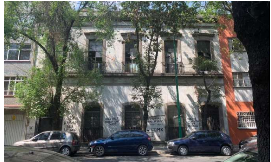
15. Fachada del estado actual del inmueble. Fotografía propia (2022)
