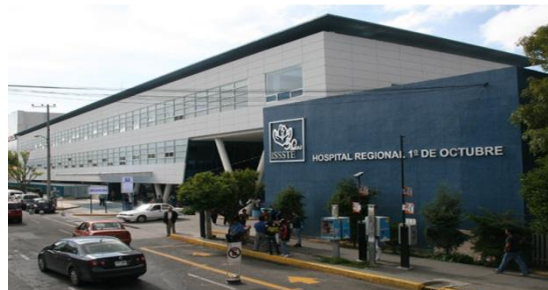
Fuente: Imagen del Hospital Regional “1° de Octubre” del ISSSTE. Google Maps
