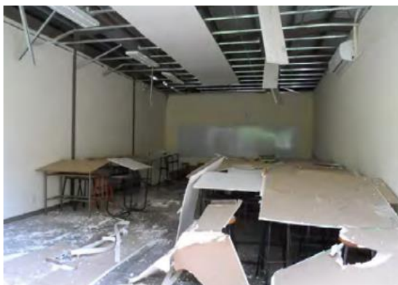
Fig. 2.6 a) Caída de luminarias y plafones b) volteo de estantes.
