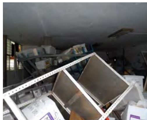
Fig. 2.6 a) Caída de luminarias y plafones b) volteo de estantes.
