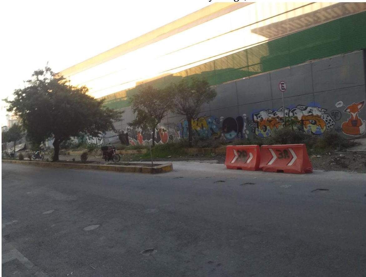
Figura 4.10 Alcaldía Benito Juárez, Ciudad de México: carril bloqueado por obras en calle Real de Mayorazgo, 2022. *
