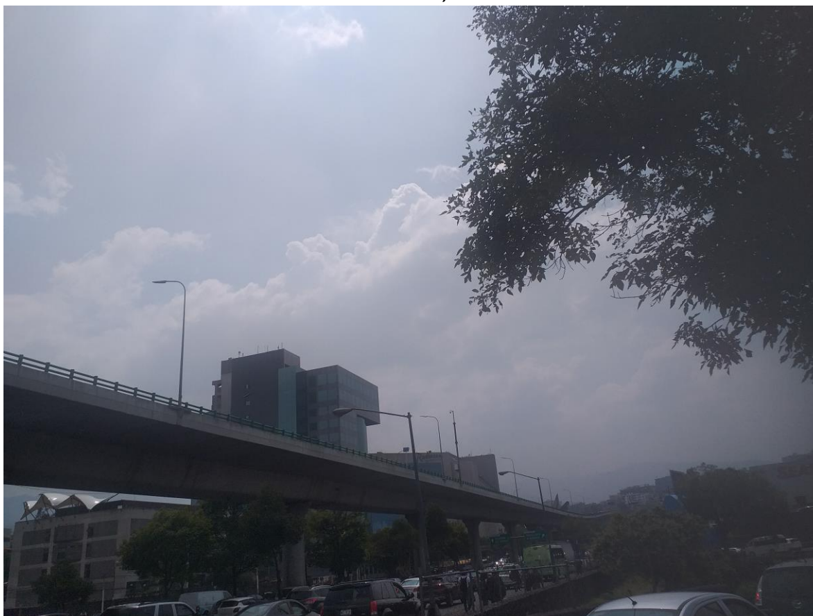
Figura 2.14 Alcaldía Tlalpan, Ciudad de México: segundo piso de la vía rápida del Periférico, 2022. *
