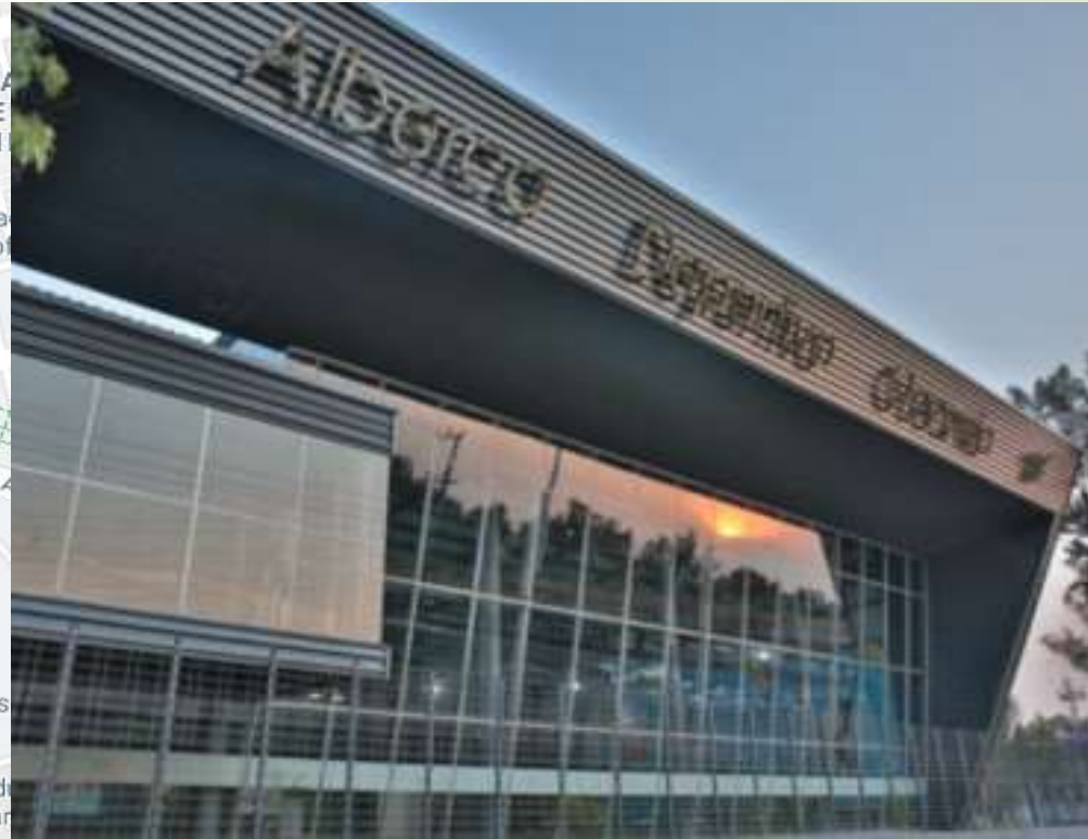
IMAGEN 31: FACHADA. FUENTE PROPIA
