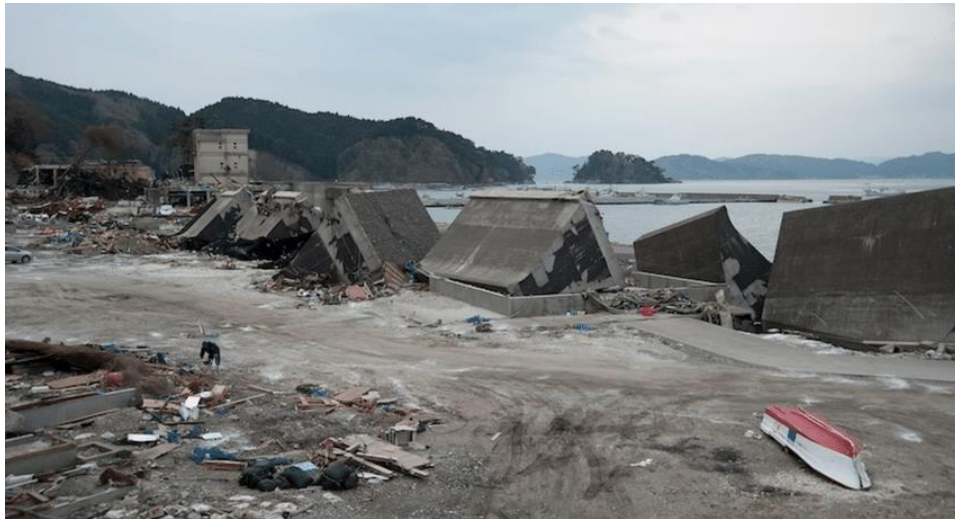
Figura 4.23 Pared de protección contra tsunamis de Tohoku después de un tsunami nivel 2 en 2011 (Marras & Mandli, 2020).
