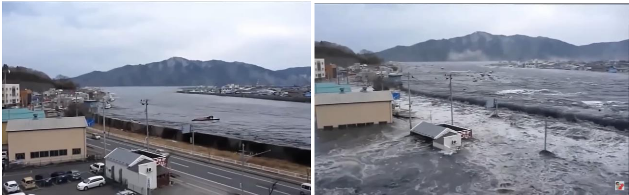
Figura 4.24 Tsunami de 2011 en Japón a) Pared de protección antes del desborde del tsunami; b) Pared de protección desbordada por el tsunami.
