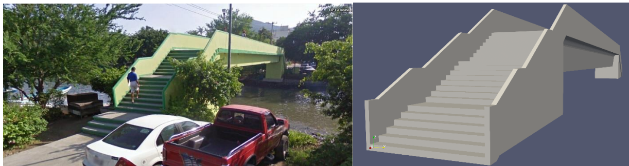
Figura 4.11 Puente peatonal La Noria-El Almacén. a) Fotografía; b) Modelo 3D.
