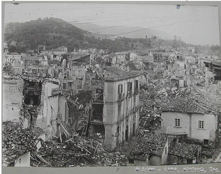
Figura 1.9 Daños por terremoto y tsunami en Messina 1908
