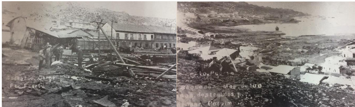
Figura 1.1 Daños causados por el tsunami de 1922 en Coquimbo, Chile.
