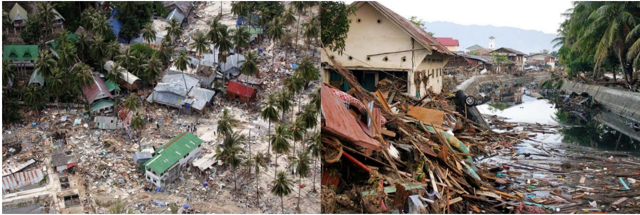
Figura 1.11 Daños por el tsunami de 2004 en Indonesia
