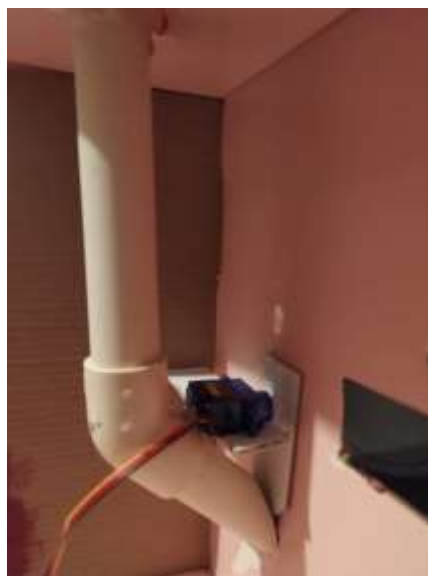
Figura 53. Instalación del ducto PVC
