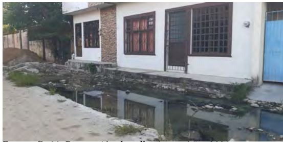
Fotografía 20. Reparación de calle: Autor. Año: 2021.
