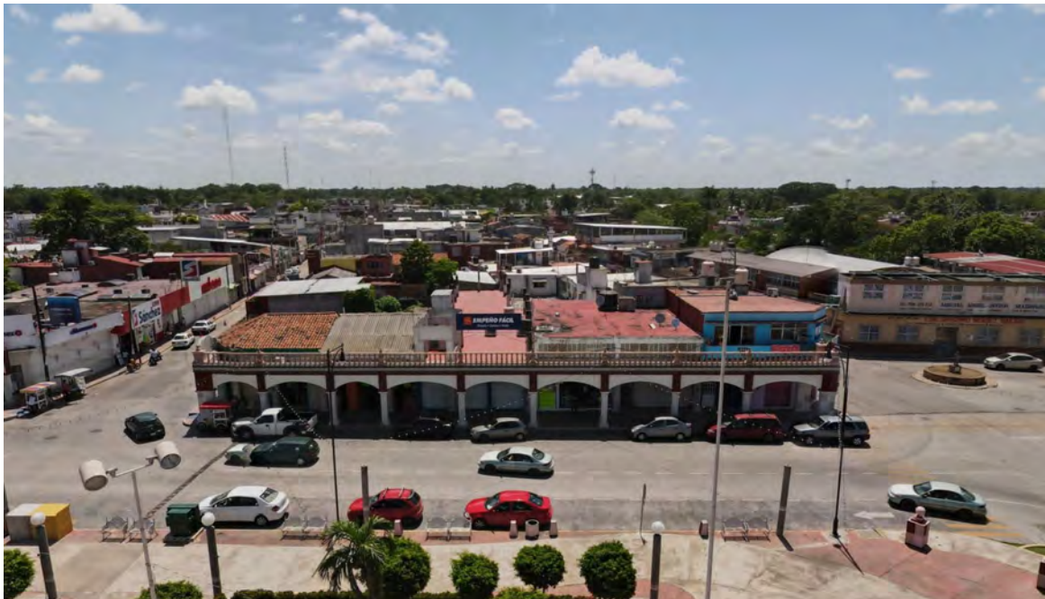
Figura 2.71 Fotografía 2. Vista hacia el oeste de la ciudad Jalpa de Méndez, desde la plaza central. Se observa en primer plano, la calle perimetral del centro de la ciudad; al horizonte, se aprecia una línea divisoria de vegetación entre el cielo y la ciudad. La construcción de los arcos en el centro histórico de la ciudad es una remodelación realizada en 2020, que tiene como finalidad embellecer la zona y promover el comercio y turismo en el municipio. Fuente: Autor. Créditos: Quetzalcoatl. Año: 2021.
