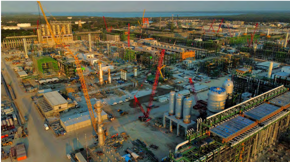
Figura 2.2 Construcción de Renifería Dos Bocas en el municipio Paraíso, Tabasco. Fuente: Líder Empresarial, 2022. Crédito: Autor desconocido. Obtenido de: https://www.liderempresarial.com/las-primeras-imagenes-de-la-refineria-dos-bocas .
