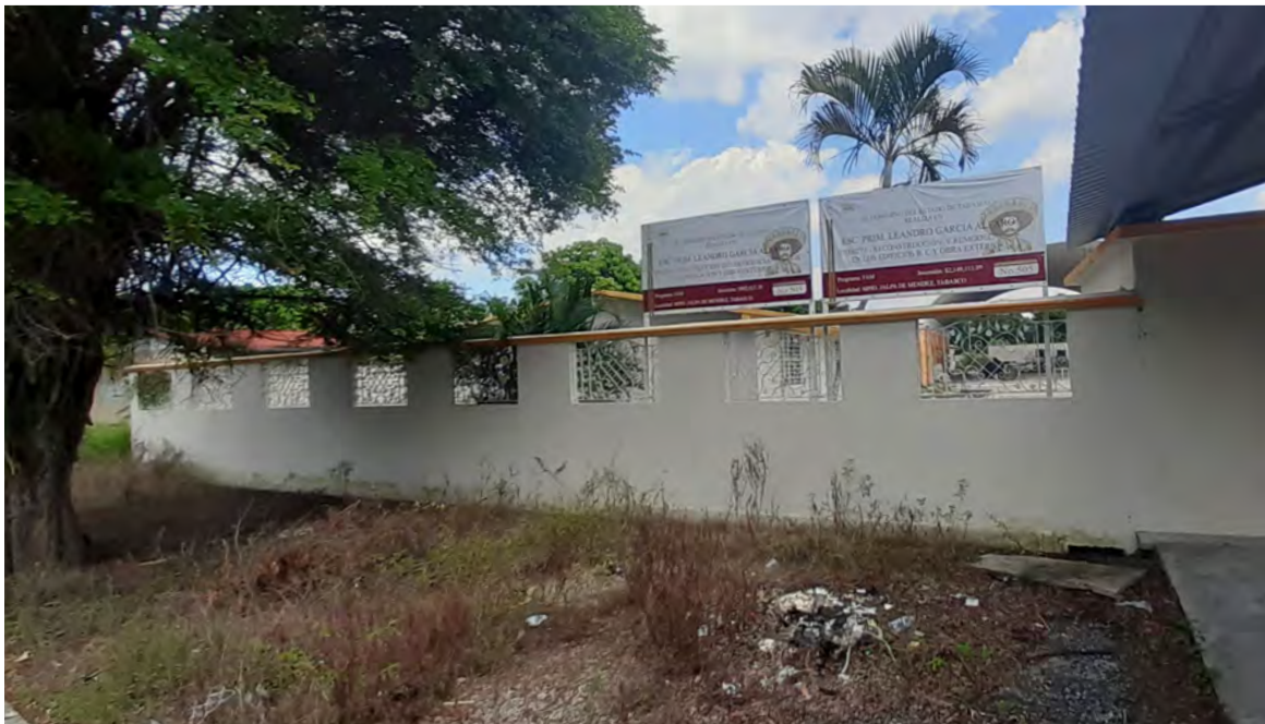
Figura 3.9 Fotografía 4. Escuela pública primaria “Leandro Gacría Alfaro”, sobre la calle Prol. Corregidora, frente a la ermita “la Resurrección”, dentro del barrio “La Resurrección”. Créditos: Autor. Año: 2021.
