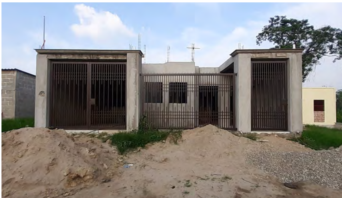
Figura 3.54 Fotografía 47. Fachada principal con orientación este de una vivienda unifamiliar ubicada sobre la única calle interna de la colonia popular al norte del rancho “El Espejo”. Se puede observar que la casa será de dos pisos, pues sobresalen los armados de varillas de acero. Créditos: Autor. Año: 2021.
