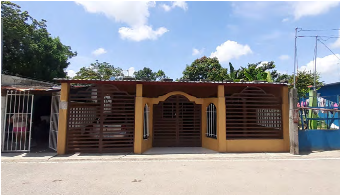
Figura 3.40 Fotografía 33. Fachada principal orientada al norte, de una vivienda unifamiliar dentro de la ranchería “El Río”. Se observa que la estructura de la vivienda ha sido construido a partir de castillos de concreto armado. La cubierta de la vivienda es de lámina galvanizada. También puede apreciarse la presencia de árboles en la parte posterior de la vivienda. Créditos: Autor. Año: 2022.
