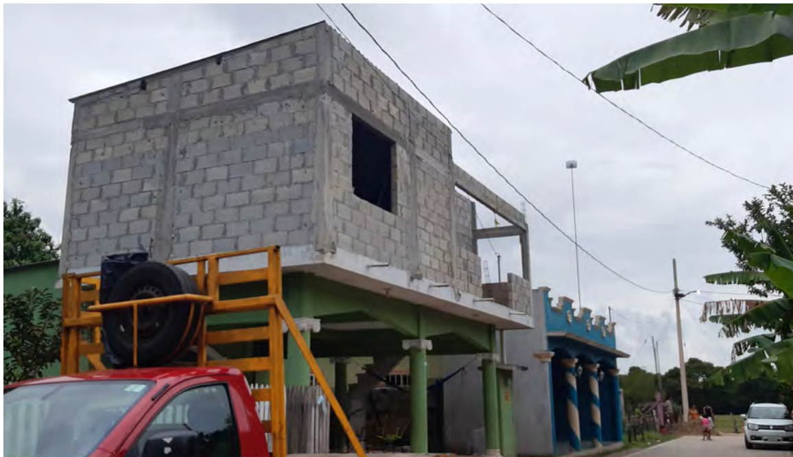
Figura 3.44 Fotografía 37. Vivienda de dos plantas dentro de la ranchería “El Río”. La segunda planta se encuentra sobre una planta libre, utilizada como cochera y patio. Créditos: Autor. Año: 2021.
