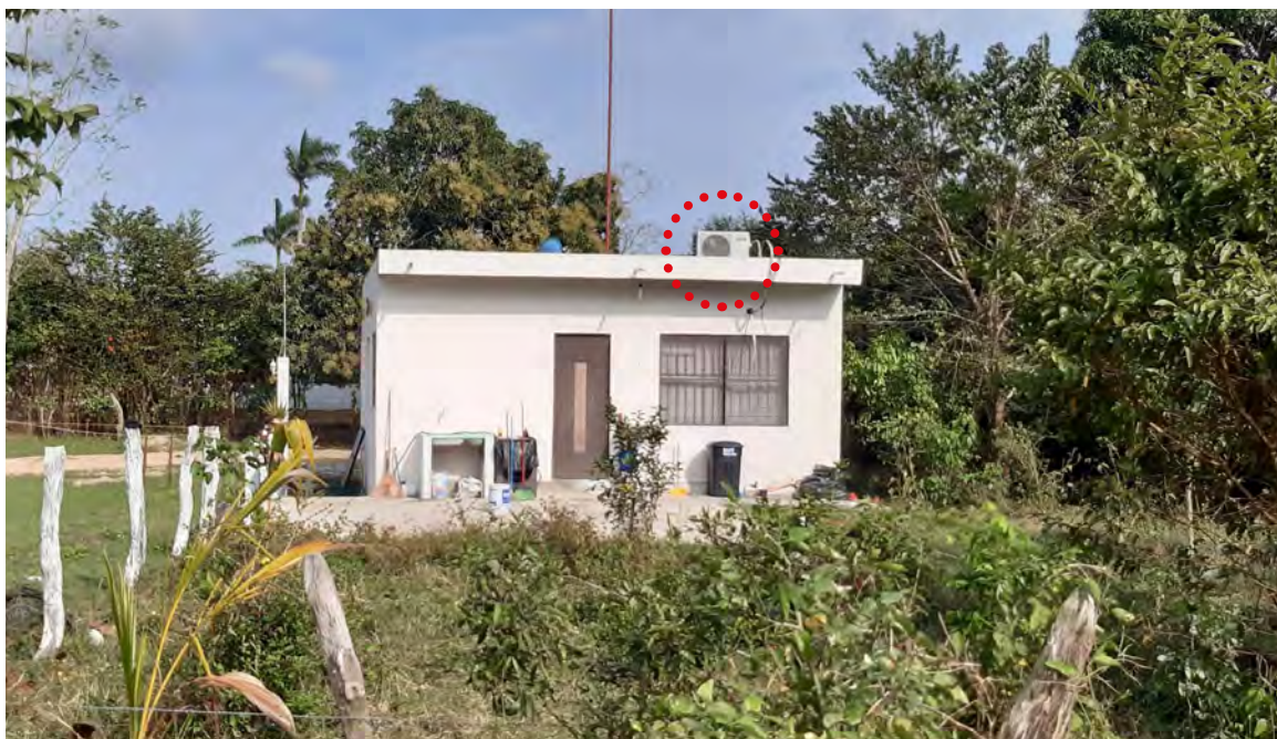
Figura 3.43 Fotografía 36. Fachada principal con orientación norte de una vivienda unifamiliar dentro de la ranchería “El Río”. Se aprecia un jardín al frente de la vivienda. Se destaca la instalación de un aire acondicionado eléctrico en la azotea de la vivienda. Créditos: Autor. Año, 2022.
