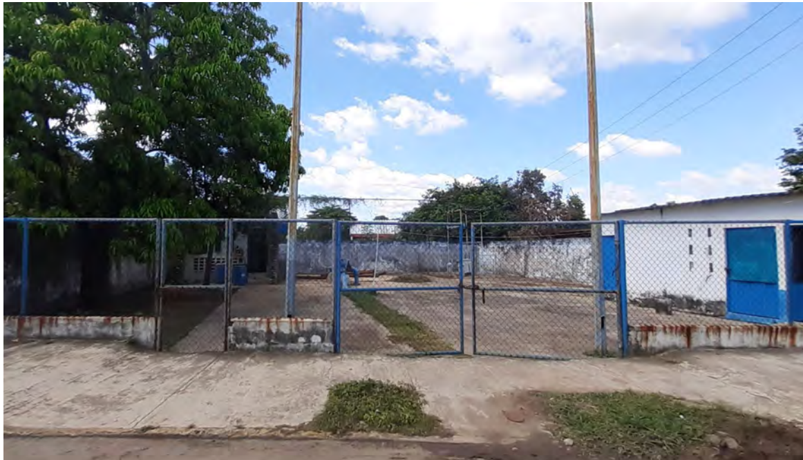
Figura 3.12 Fotografía 7. Potabilizadora de agua de la ciudad Jalpa de Méndez, Tabasco sobre calle Prol. Corregidora, a un costado de la escuela secundaria federal “Coronel Gregorio Méndez Magaña”. Dentro del rancho “El Espejo” se encuentra una de las potabilizadoras de agua municipales. Créditos: Autor. Año: 2021.
