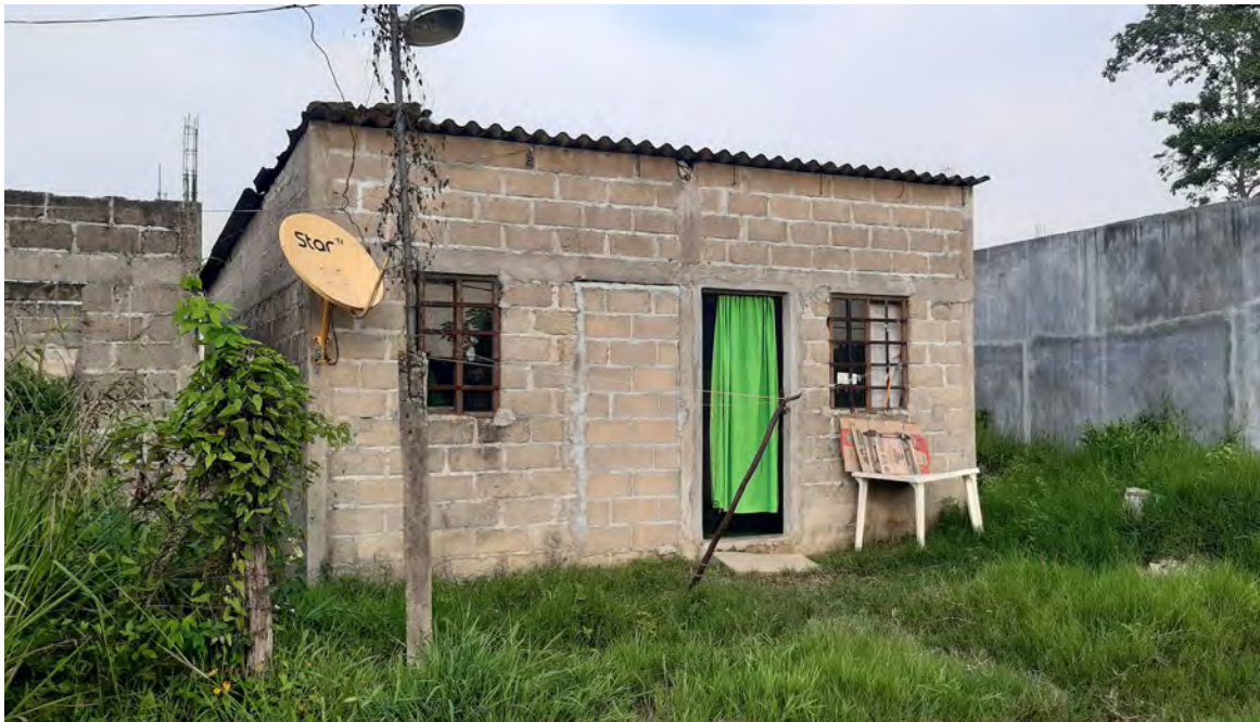
Figura 3.56 Fotografía 49. Vivienda en construcción dentro de la colonia popular al norte del rancho “El Espejo”. Puede observarse que el material de construcción utilizado es block de concreto. Créditos: Autor. Año: 2021.
