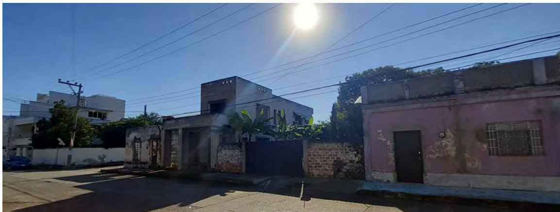
Figura 1.18 Viviendas recibiendo la radiación solar directamente sobre sus superficies, ya que no se contempla el aprovechamiento de sombra natural. Créditos: Autor. Año: 2021.
