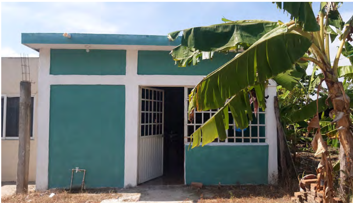
Figura 3.41 Fotografía 34. Fachada principal con orientación sur de una vivienda unifamiliar dentro de la ranchería “El Río”. Se observa que esta vivienda cuenta con cubierta de losa sostenida por columnas de concreto armado. La vivienda también cuenta con suministro de agua potable. Créditos: Autor. Año: 2022.
