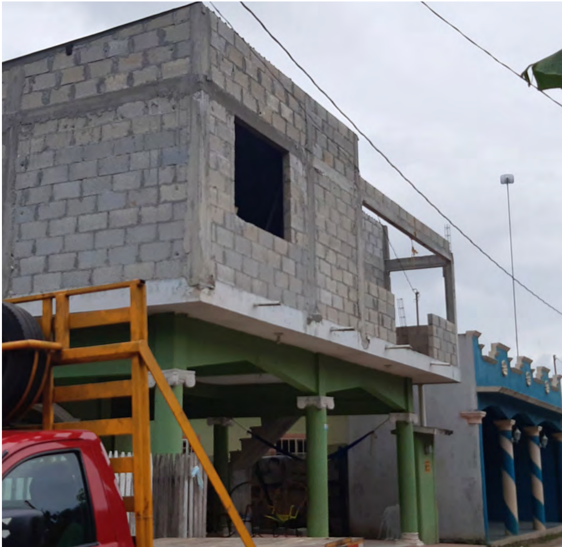
Figura 1.16 Vivienda construida con block de concreto en el municipio Jalpa de Méndez, Tabasco. Créditos Autor. Año: 2021.
