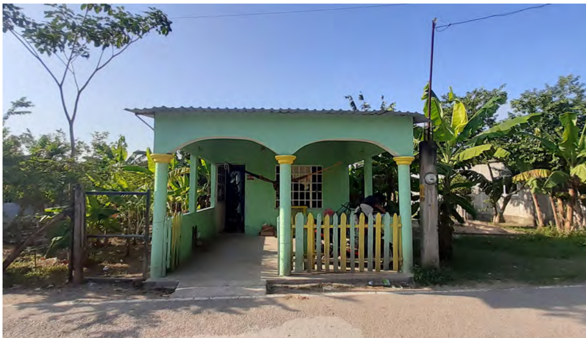
Figura 3.42 Fotografía 35. Fachada principal con orientación sur de una vivienda unifamiliar. La vivienda ha sido construida con block de concreto y tiene una cubierta de lámina galvanizada. Se observa que la casa se encuentra en medio de dos huertos familiares. Créditos: Autor. Año: 2022.
