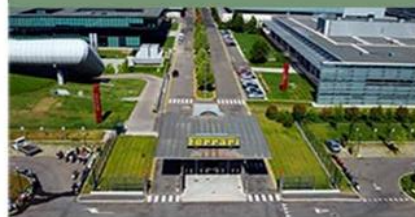
LOGRAR QUE ESTA INDUSTRIA CONTRIBUYA CON EL MANTENIMIENTO DE SU ENTORNO Y SUS ÁREAS EXTERIORES PROXIMAS AL PROYECTO COMO JARDINERAS Y BANQUETAS.
