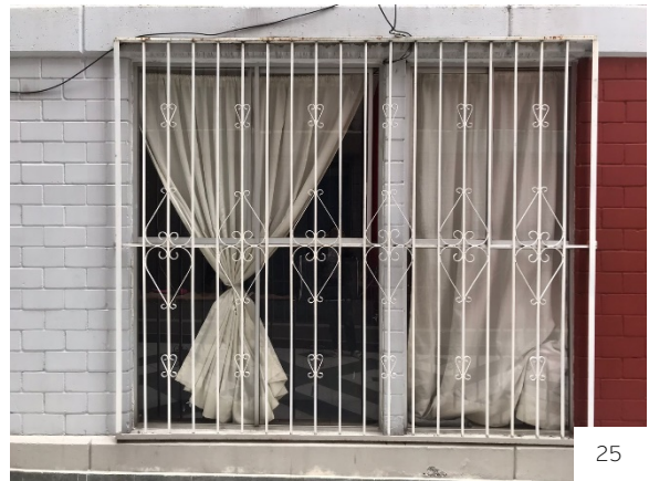
Imagen 22-25 Fotografías de los vanos dirigidos al interior del edificio (circulaciones centrales) Castro Gonzalez Daniela 2022
