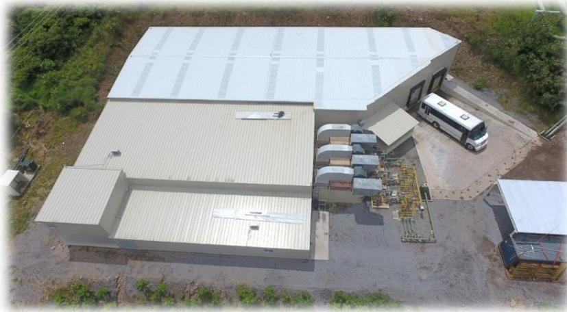
Figura 1 Planta agroindustrial DGA de Nayarit
