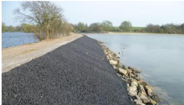
Figura 4.1 Protección de estribos en rio pavimento.
