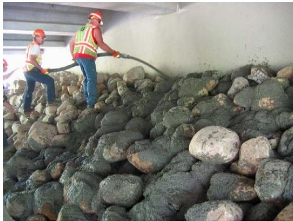
Figura 4.2 Inyección de concreto a material graduado
