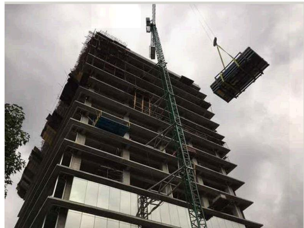
Fig. 72 Izaje de módulos prefabricados con grúa torre
