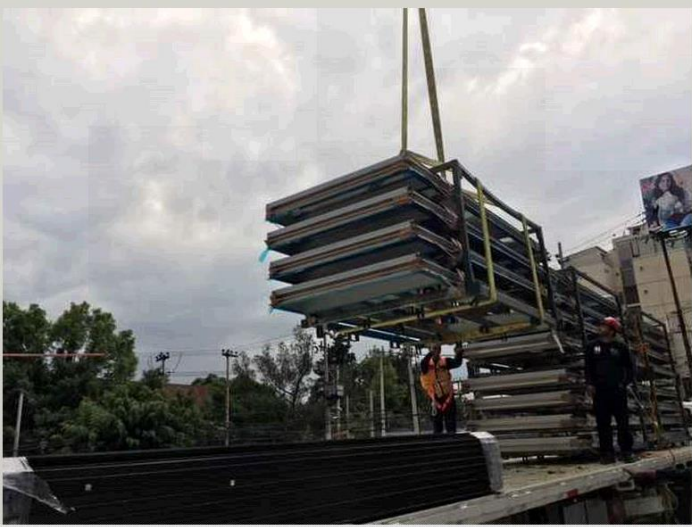
Fig. 71 Módulos prefabricados transportados en canastillas y tráiler.
