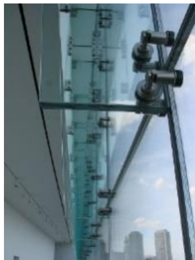
Figura 59. Fachada suspendida con costilla y conectores
