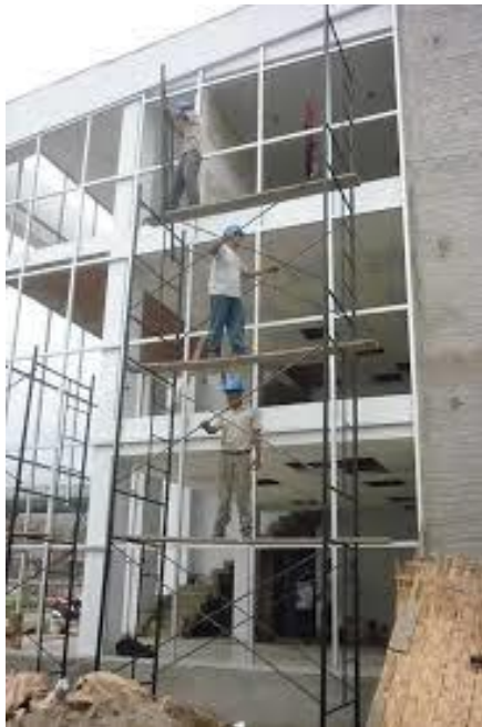
Colocación de estructura soportante y vidrios en obra
