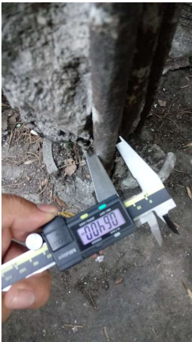
Figura 25.- Medición de diámetro de varilla en columnas 20T.
