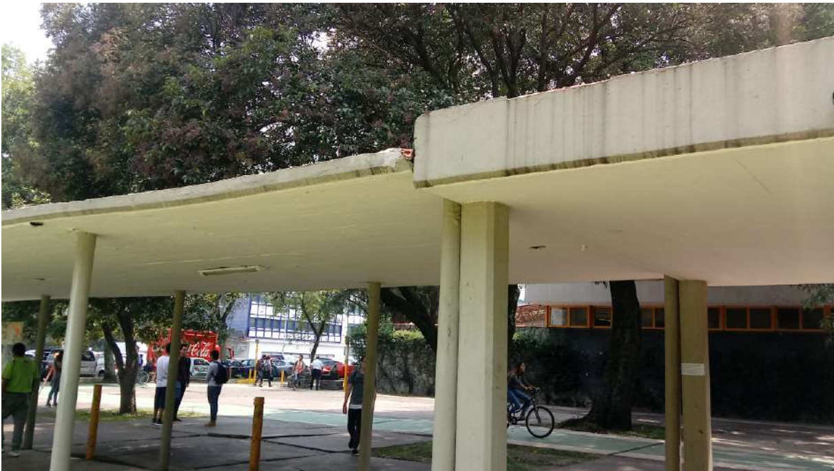
Figura 9.- El pasillo que conecta a la unidad multidisciplinaria de la Facultad de Arquitectura con el edificio principal de la Facultad de Arquitectura, a la izquierda la estructura original, y a la derecha la estructura modificada.
