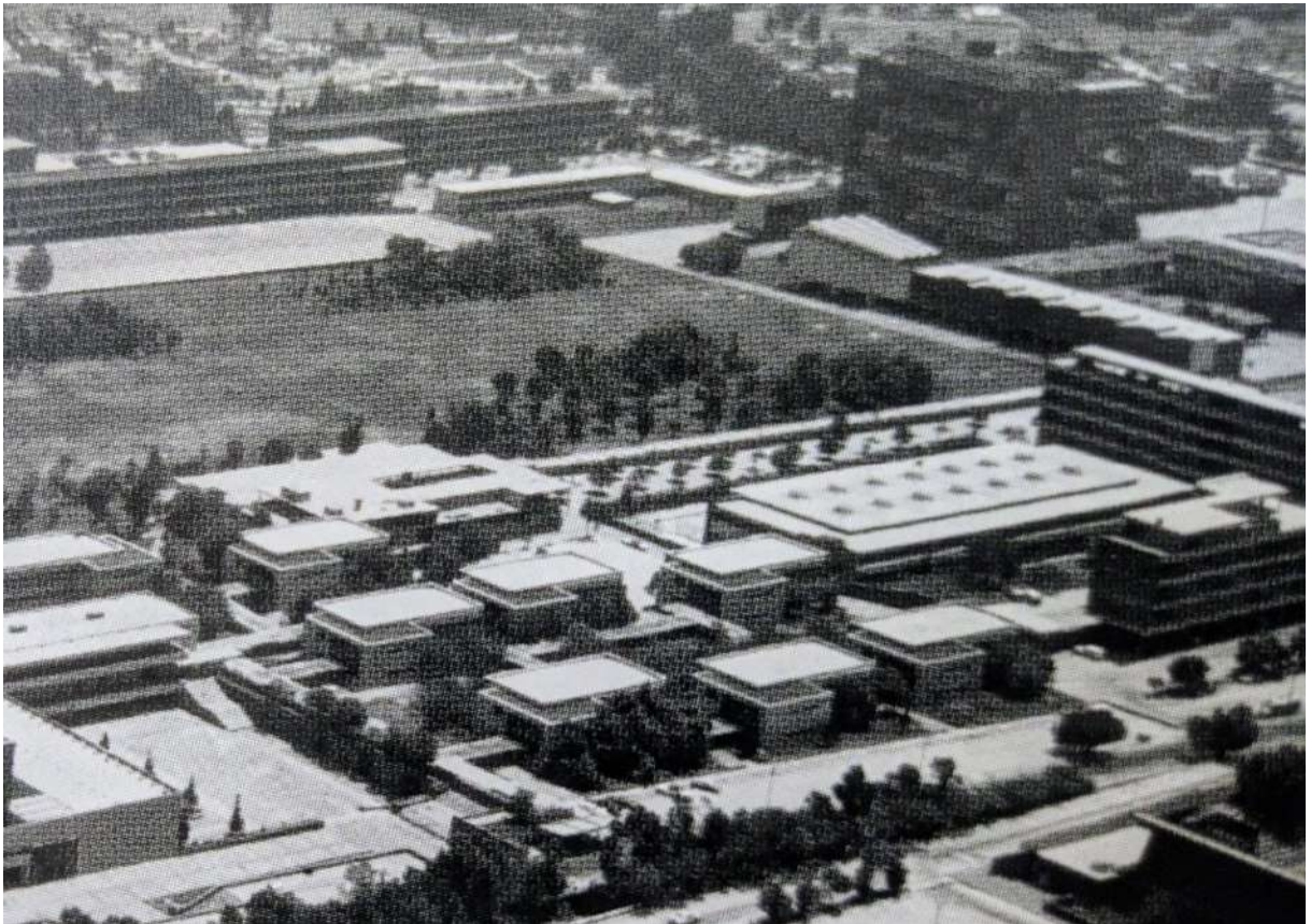
Figura 6.- Pasillos en 1955 ICA.
