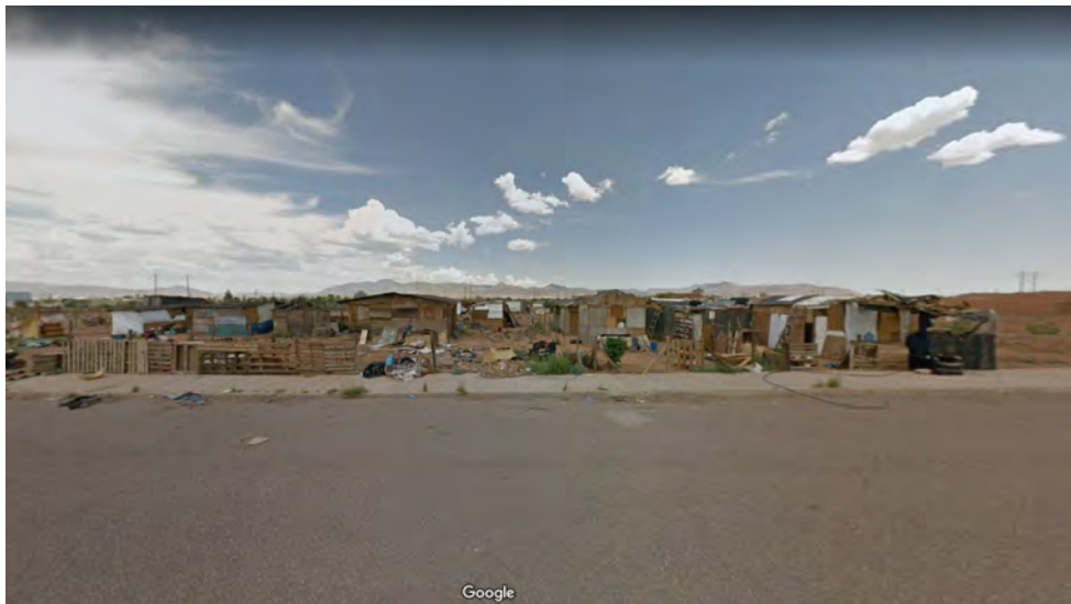
Vista 8. Asentamiento Carlos Díaz Infante Imágen obtenida de Google Maps
