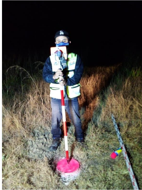
Figura 26. Posicionamiento planimétrico de bancos de nivel.
