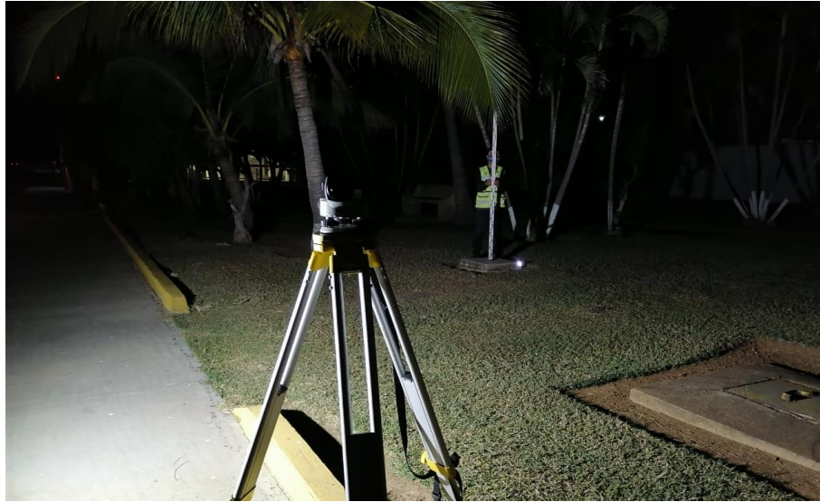
Figura 3. Levantamiento topográfico nocturno en el aeropuerto.
