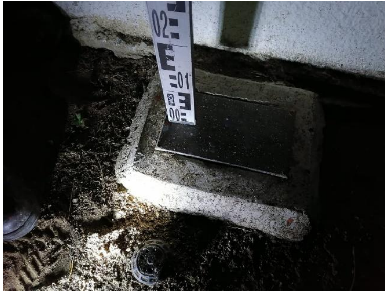
Figura 25. Nivelación desde el banco de nivel maestro.
