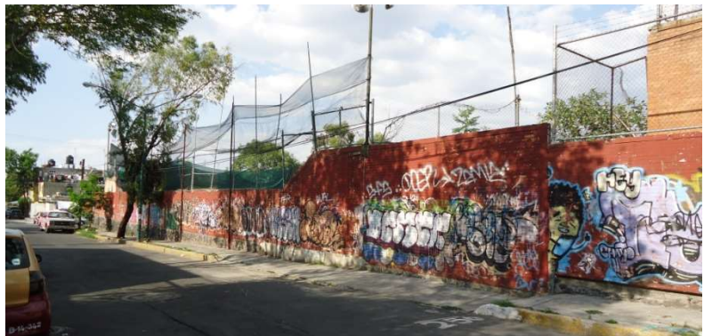
Foto 4. En esta fotografía se aprecia el límite oeste del predio con la Calle San Celso.
