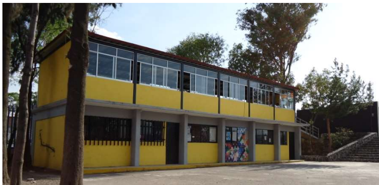
En esta imagen se observa el edificio de usos múltiples.
