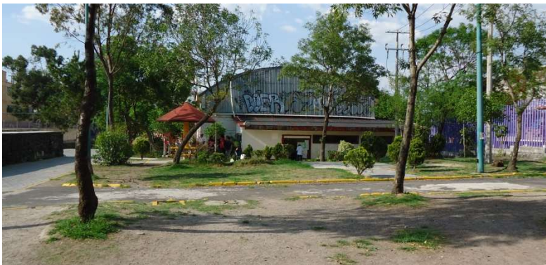
En esta imagen se observa el edificio de la alberca.
