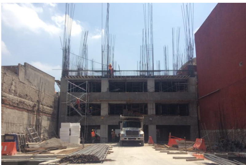
Armado de columnas de acero y armado de losa. Se comienzan trabajos de albañilería en Torre B.
