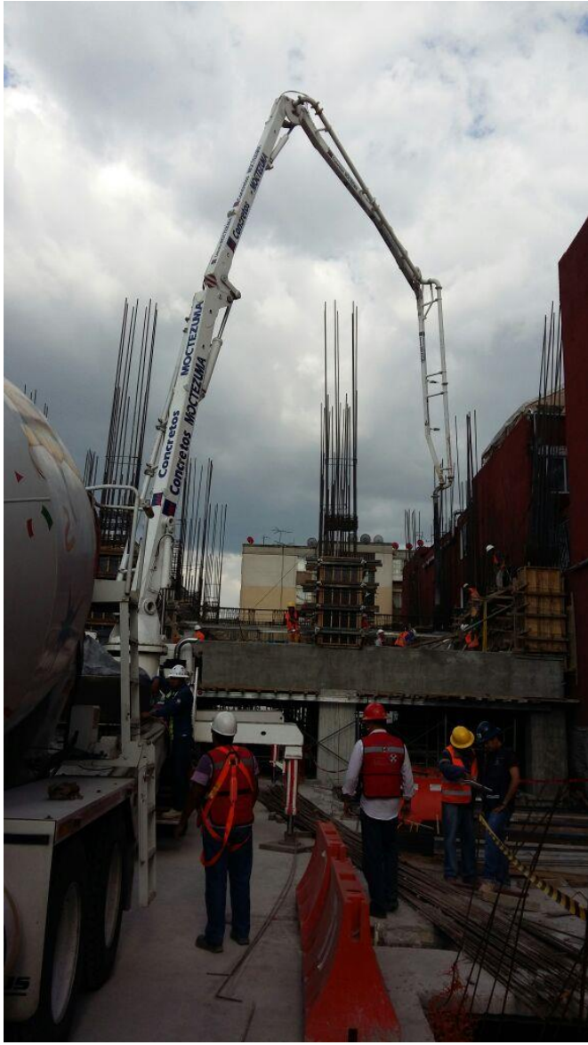
Armado de columnas de acero y armado de losa. Se comienzan trabajos de albañilería en Torre B.
