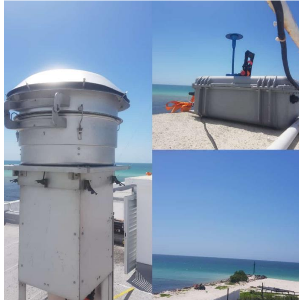
Figura 12. Vista de la instalación de equipos en Sisal, Yucatán
