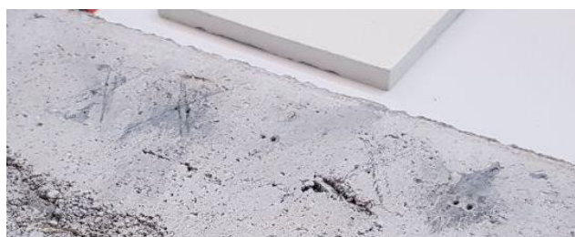
Imagen 47: Barrenos de 1/16" para la instalación del sensor de difusividad térmica de doble aguja en Neublock
