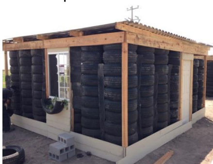
Imagen 13: Casa fabricada con llantas de desecho. Fuente: Manejo responsable de llantas usadas A.C. (2015)
