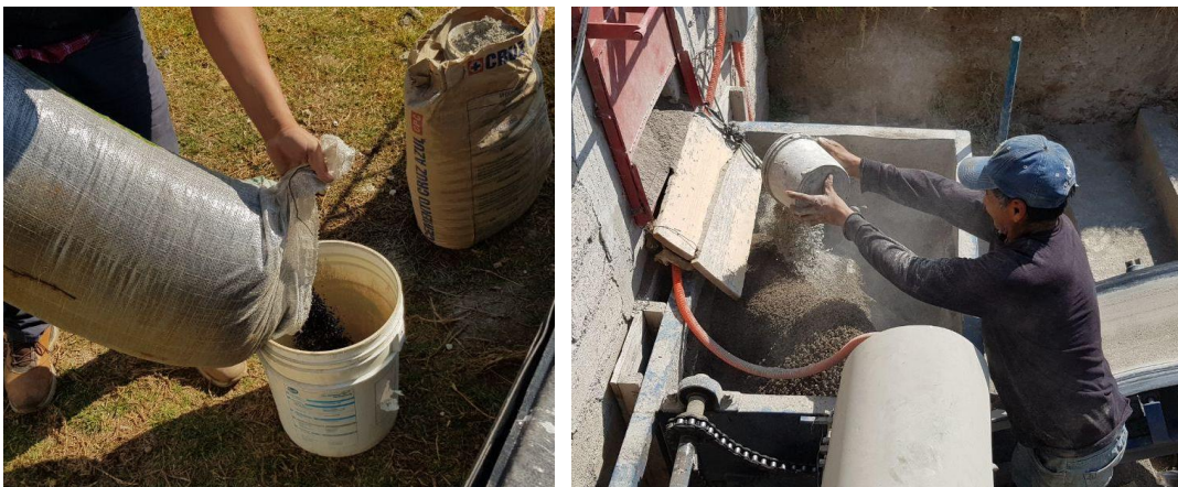
Imagen 34: Elaboración de Neublock en planta
