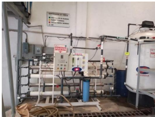
Figura 7. Sistema para el tratamiento del agua.
