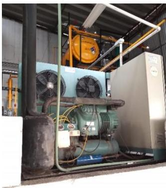
Figura 9. Condensadora y compresor.
