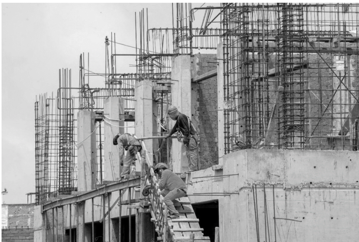
5. Dinamismo del Sector de la Construcción.
