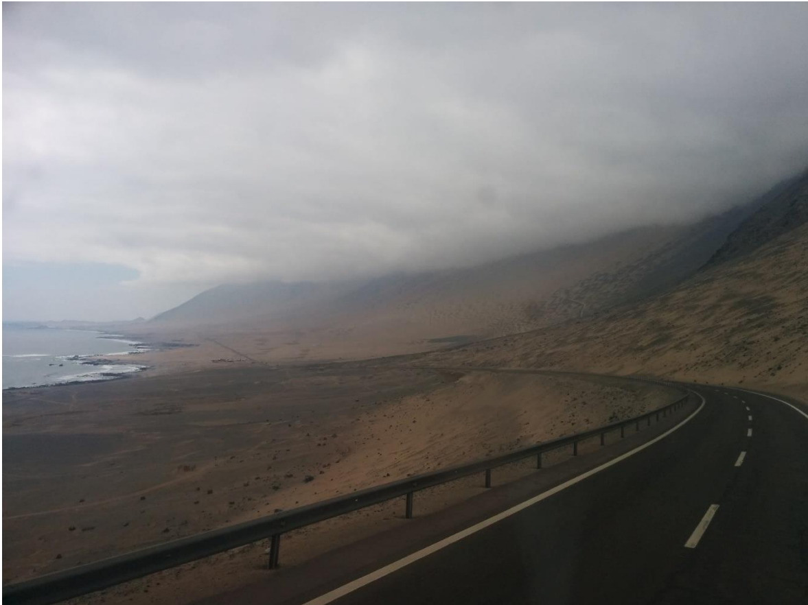
Carretera, tramo Antofagasta-Iquique.
