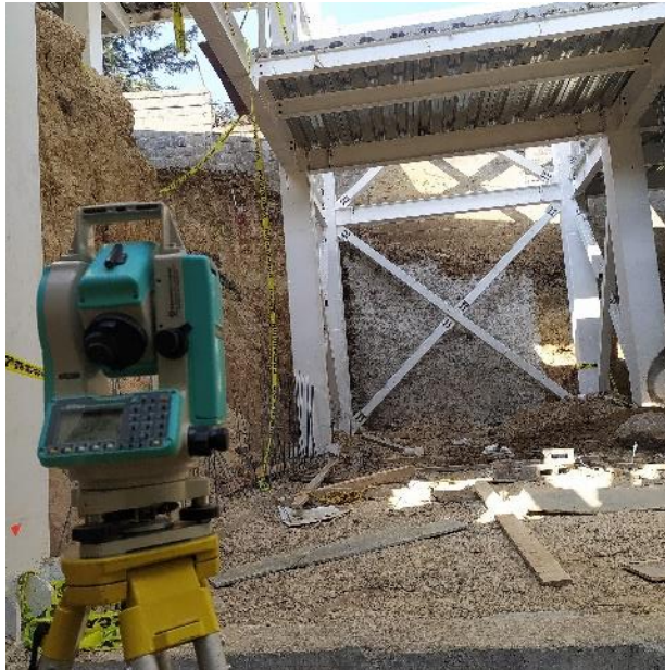
Imagen 17. Monitoreo de verticalidad de columnas con estación total
