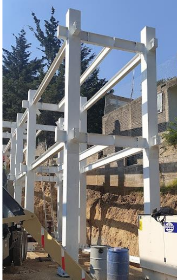
Imagen 9. Columna como elemento estructural
