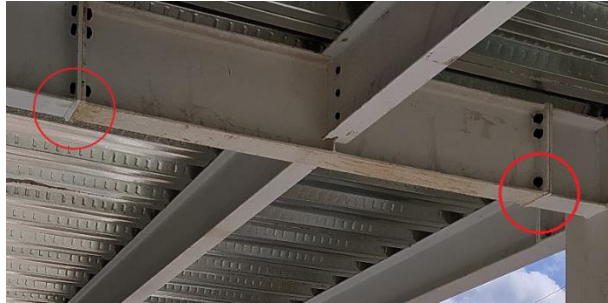
Imagen 21. Conexiones de elementos estructurales
