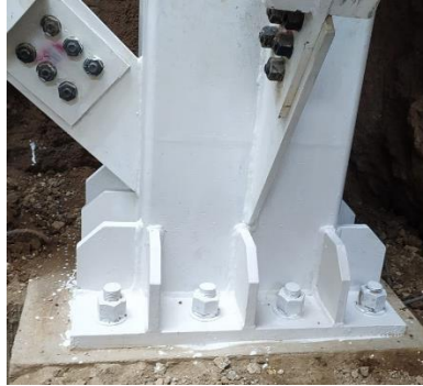
Imagen 11. Apoyo tipo empotramiento como elemento estructural
