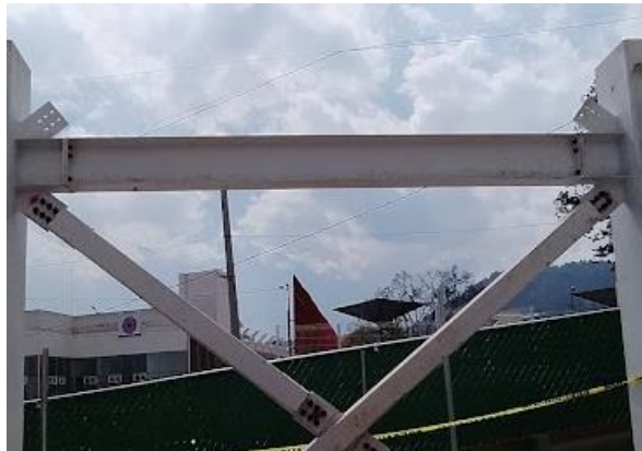
Imagen 10. Viga de acero como elemento estructural
