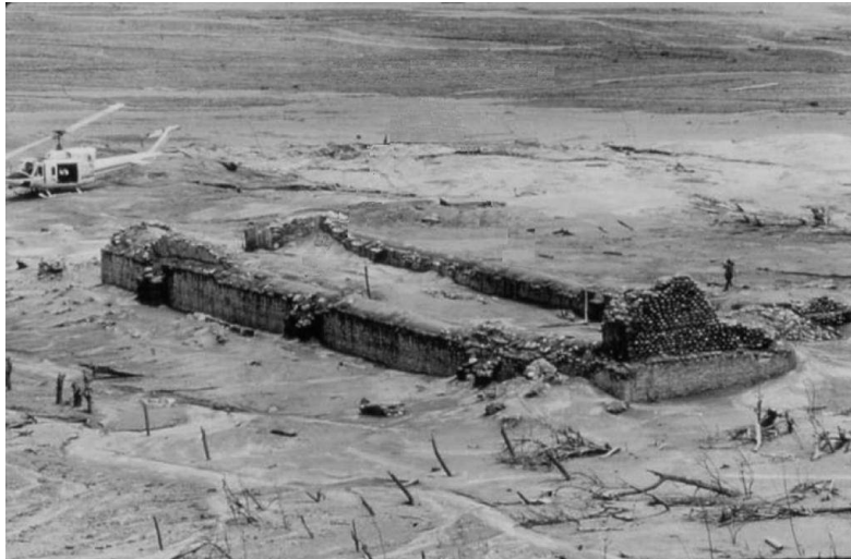
Figura 1.1: Muros de la iglesia de Francisco León Foto: Robert Tilling, 1982
