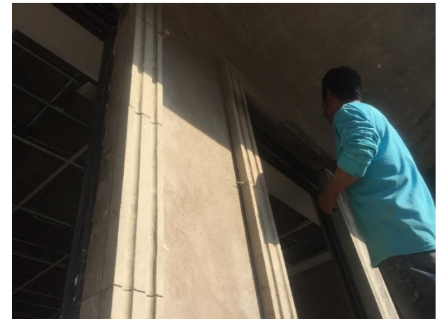
Marcos de ventanas, puertas y remate de muros con cantera rosa natural
