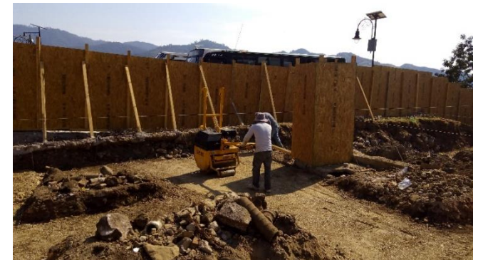
Relleno con material inerte (tepetate) en capas de 20 cm de espesor, compactado a 90% P.P.S
