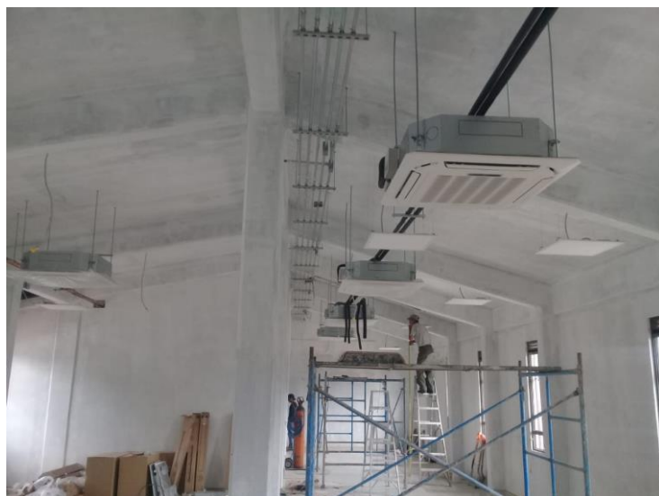
Sistema de aire acondicionado caliente-frío en área de dormitorios
