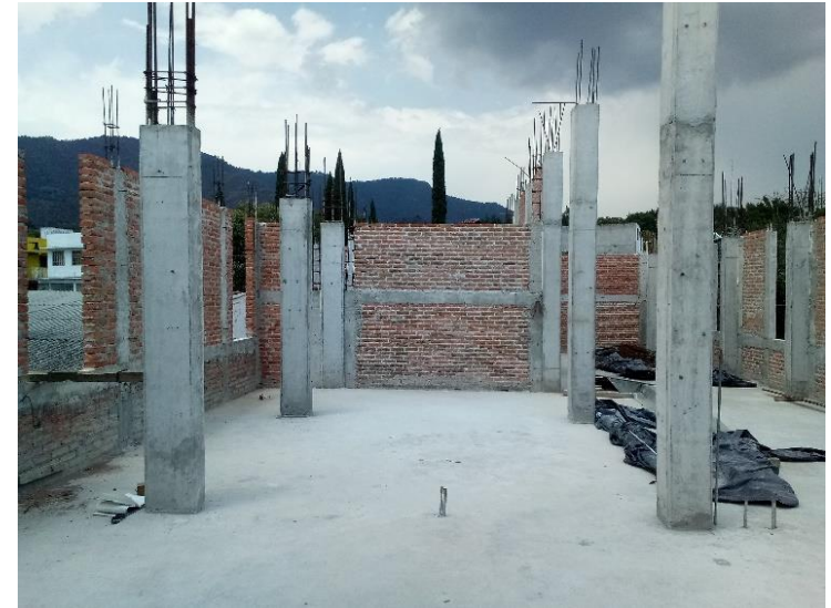
Columnas de concreto armado 2do. Nivel.
