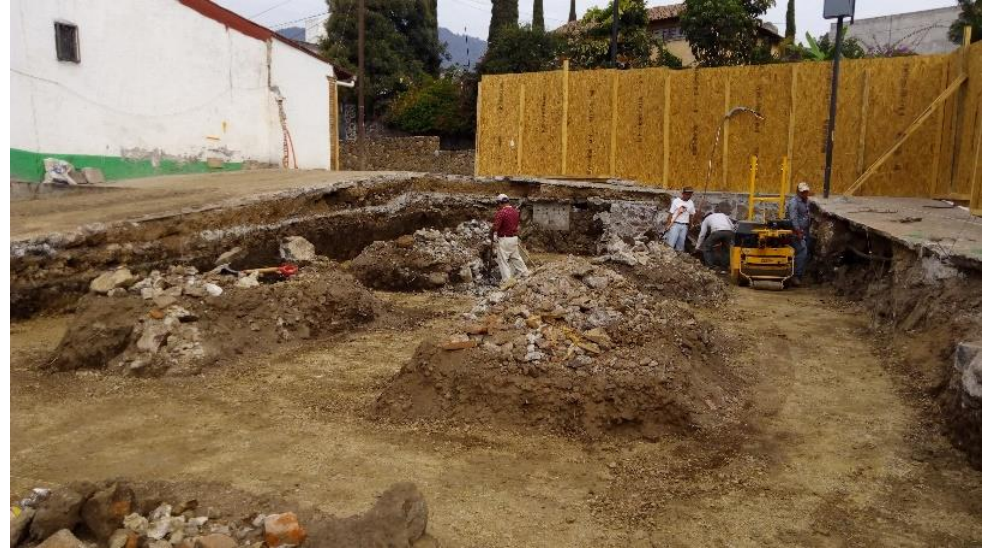
Colocación de tapial de madera para delimitar y proteger el área de trabajo.
