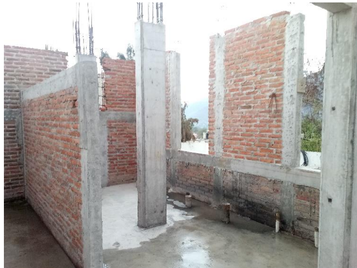
Estructura de concreto armado en 2do. Nivel.
