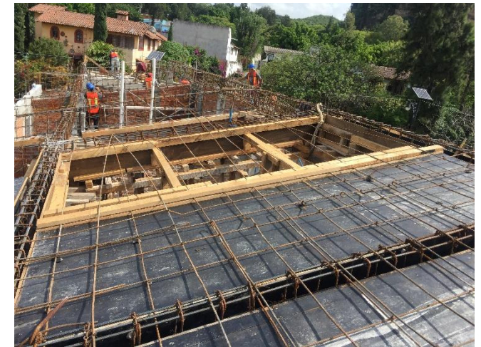
Cimbra de madera acabado aparente en losa terminal 2do. Nivel.
