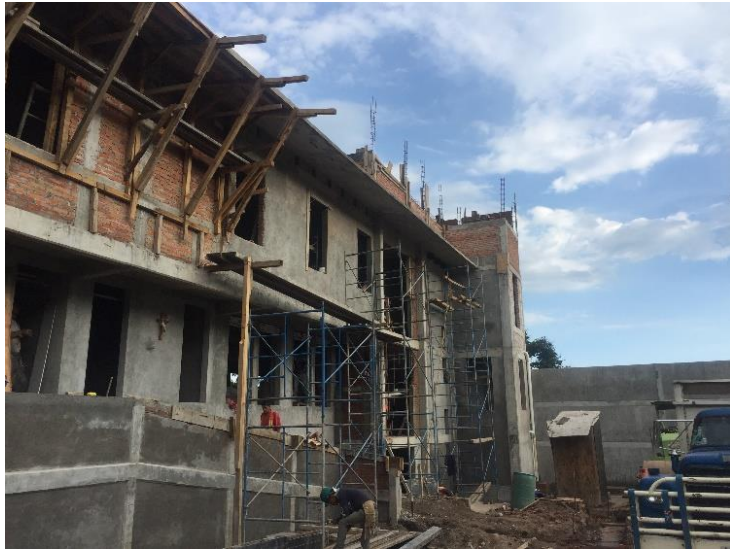
Bardas perimetrales, aplanados en muros exteriores y registros para tratamiento de aguas negras.
