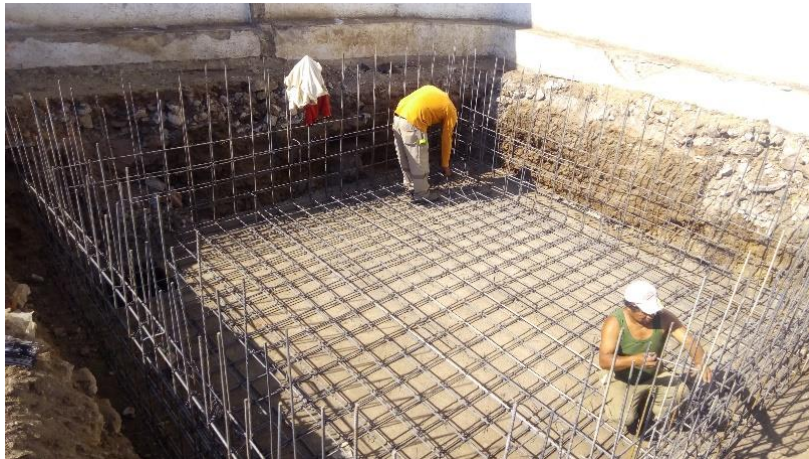
Muros de concreto para armería Baja.
