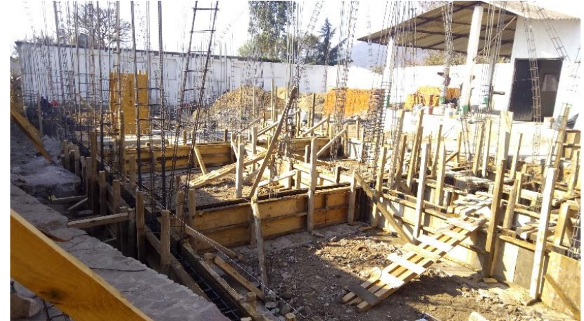
Habilitado de cimbra acabado común en cimentación.
