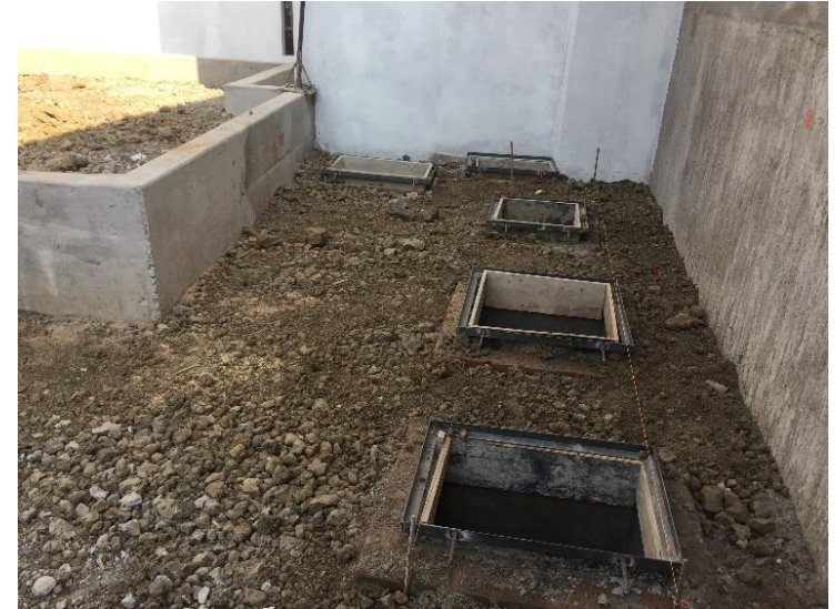
Bardas perimetrales, aplanados en muros exteriores y registros para tratamiento de aguas negras.
