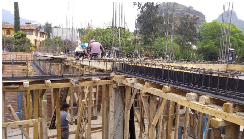
Habilitado cimbra y armado de acero en traves. planta baja.
