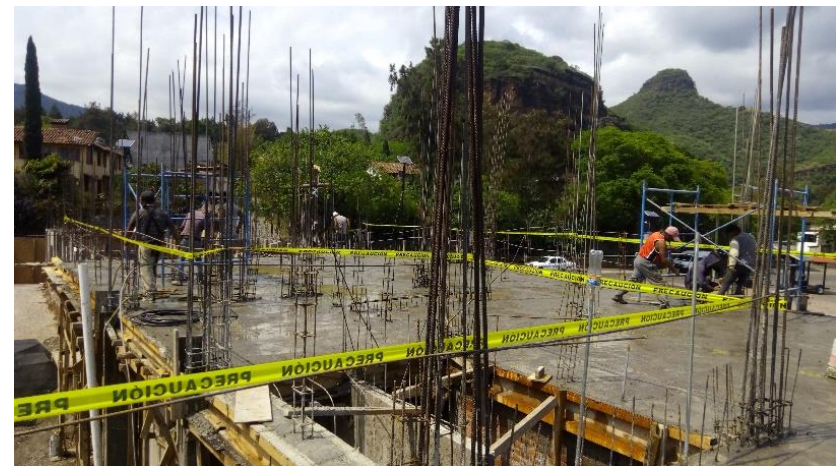
Losa de concreto armado 1er. Nivel.
