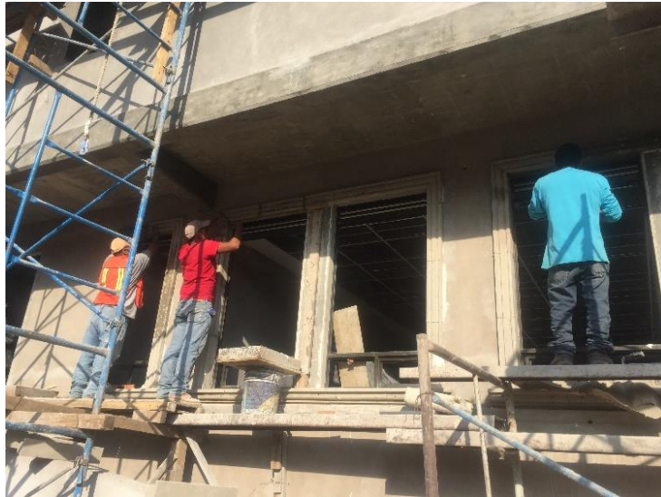
Marcos de ventanas, puertas y remate de muros con cantera rosa natural
