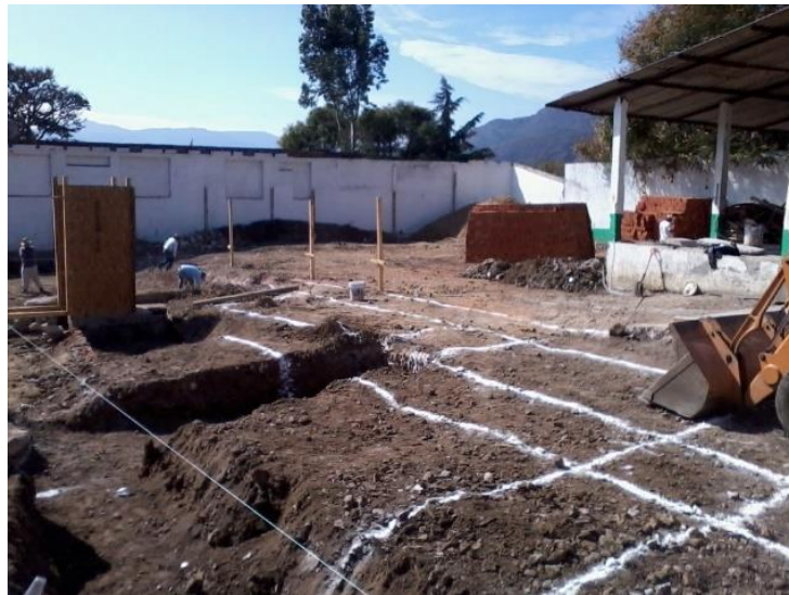
Trazo y nivelación para desplante de estructuras.
