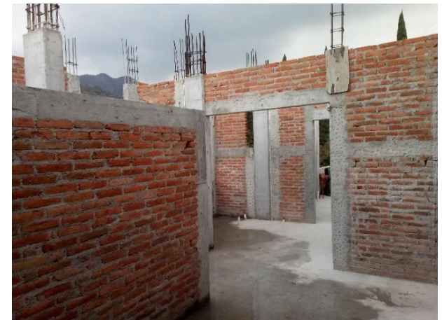
Muros de tabique, cadenas y castillos 2do. Nivel.
