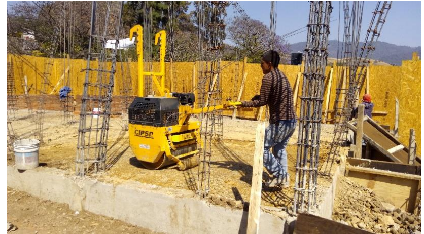
Relleno con tepetate compactado para alcanzar niveles de proyecto.
