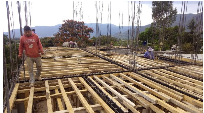
Habilitado de cimbra en losa planta planta baja.
