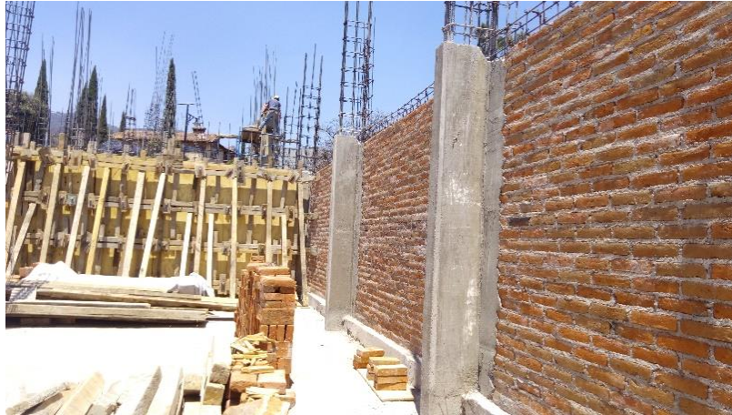
Muros de tabique y concreto en 1er. Nivel.
