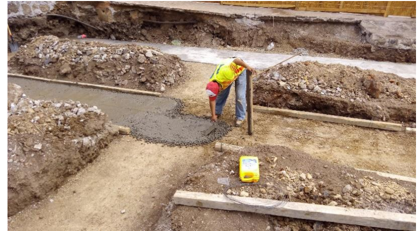
Se fabricó la Plantilla sobre terreno compactado con frontera de madera.
