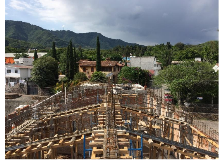
Cimbra de madera y armado de acero en traves 2do. Nivel.
