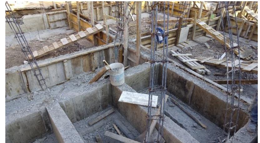
Descimbrado de cimentación.
