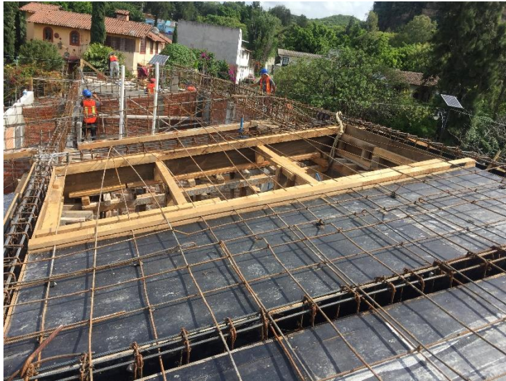
Armado de losa y colado con concreto premezclado bombeado en losa 2do. Nivel.
