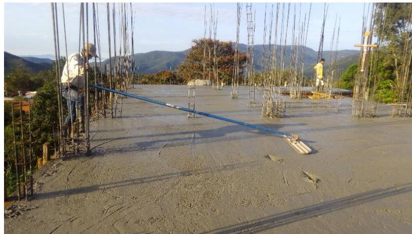
Nivelación y acabado de concreto en losa 1er. Nivel.
