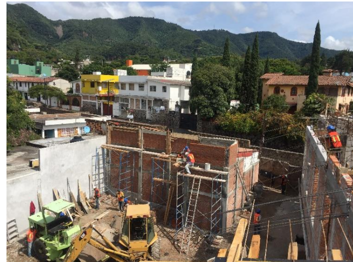
Bardas perimetrales, aplanados en muros exteriores y registros para tratamiento de aguas negras.
