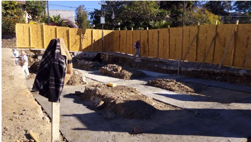
Se fabricó la Plantilla sobre terreno compactado con frontera de madera.
