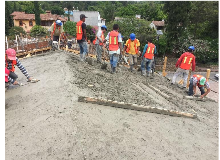
Armado de losa y colado con concreto premezclado bombeado en losa 2do. Nivel.
