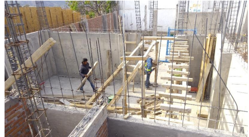
Estructura de concreto 1er. Nivel.
