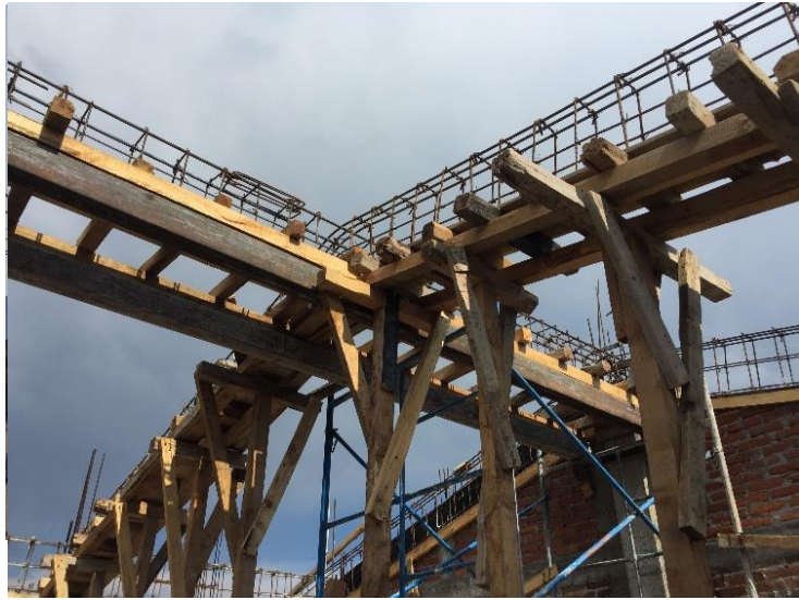
Estructura de concreto armado en 2do. Nivel.
