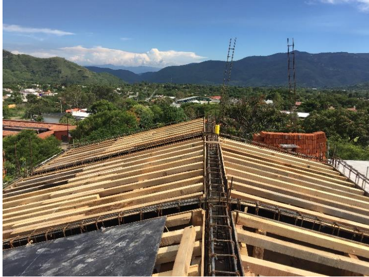
Cimbra de madera y armado de acero en traves 2do. Nivel.
