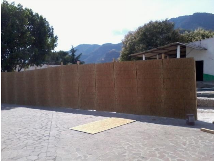
Colocación de tapial de madera para delimitar y proteger el área de trabajo.
