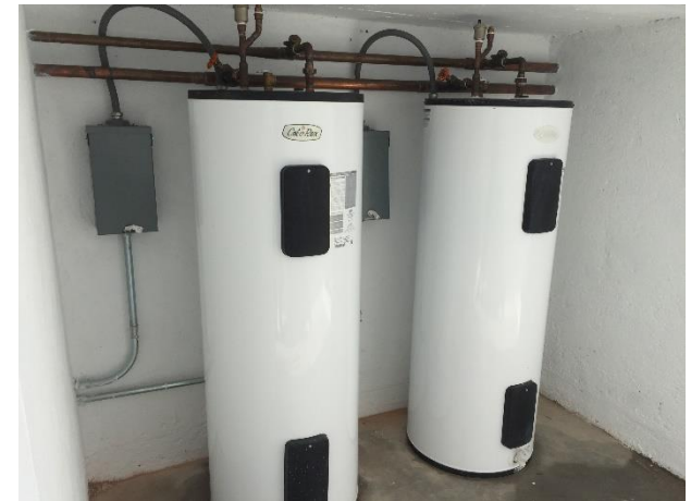
Baños vestidores con suministro de agua con calentadores eléctricos
