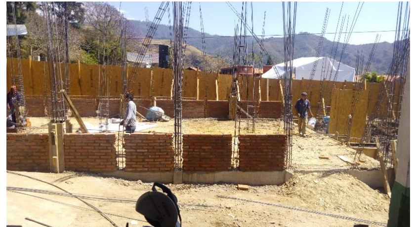
Muros de tabique rojo
