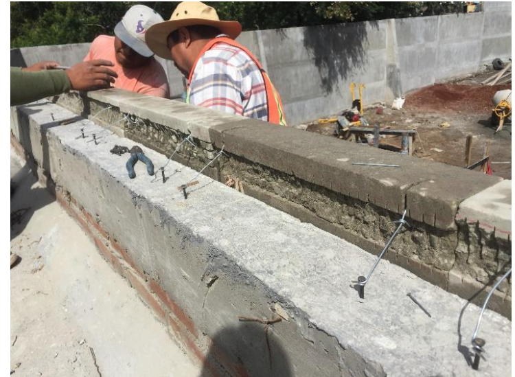
Marcos de ventanas, puertas y remate de muros con cantera rosa natural
