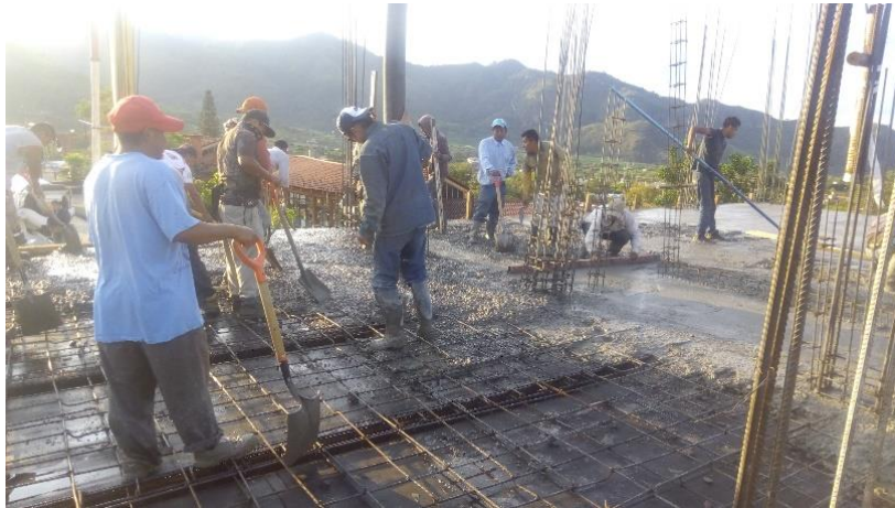
Colocación y tendido de concreto en losa 1er. Nivel.
