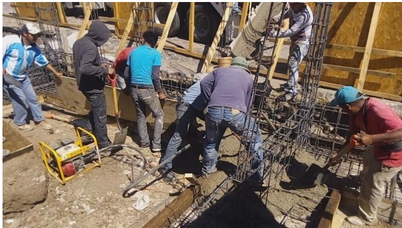
Concreto premezclado f'c=250 kg/cm 2 en cimentación.
