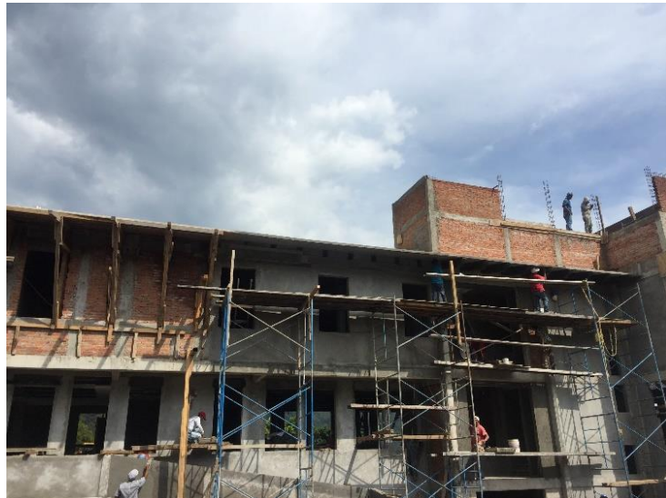
Bardas perimetrales, aplanados en muros exteriores y registros para tratamiento de aguas negras.
