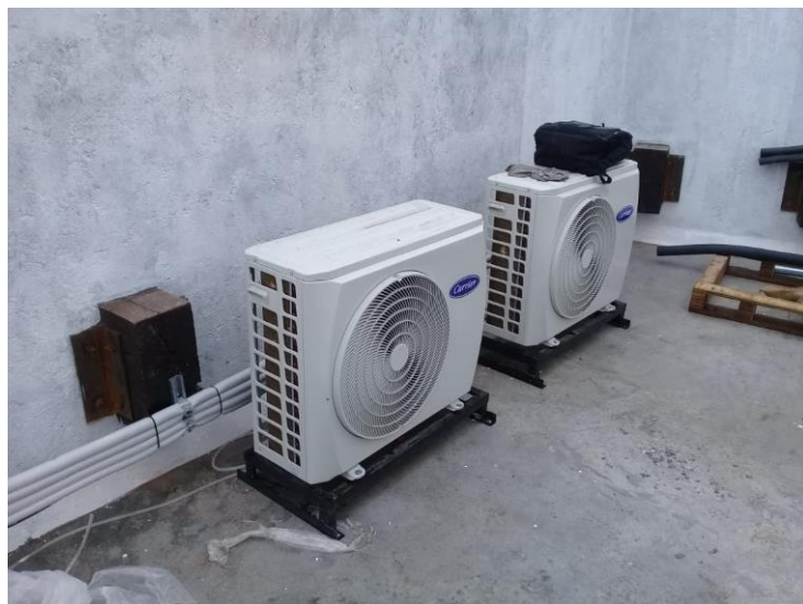
Sistema de aire acondicionado caliente-frío en área de dormitorios
