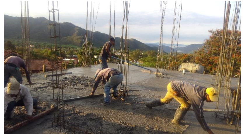
Colocación y tendido de concreto en losa 1er. Nivel.
