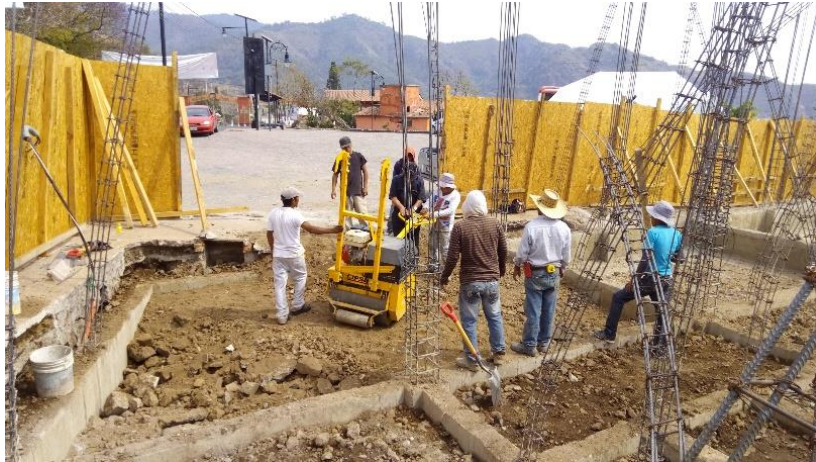
Relleno con tepetate compactado para alcanzar niveles de proyecto.
