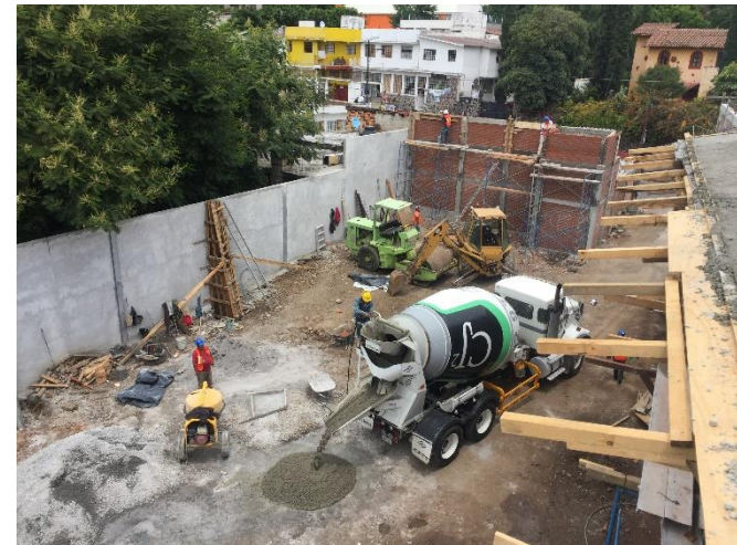
Concreto premezclado bombeable para losa 2do. Nivel.
