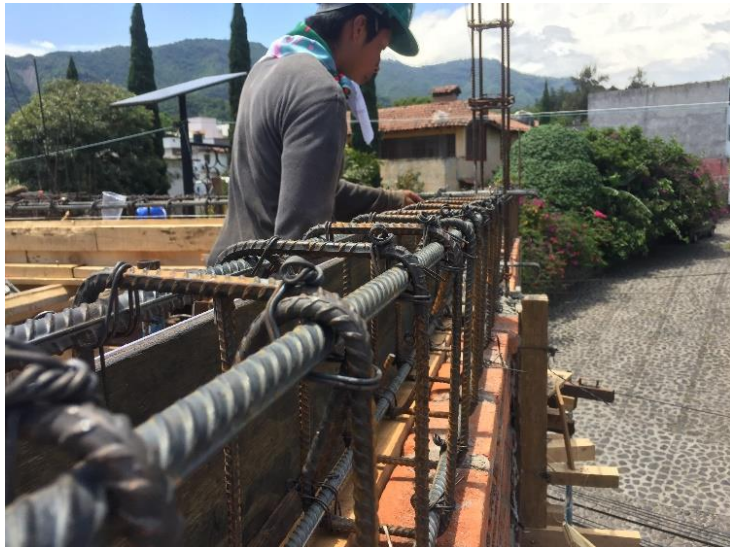
Armado de traves con acero de refuerzo como lo indica el proyecto en traves 2do. Nivel.
