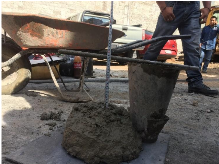
Prueba de revenimiento del concreto premezclado para losa de 2do. Nivel.
