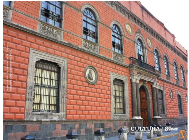
Fig. 2.1 Fachada de la Academia Nacional de San Carlos. (Navarrete J, 2019)
