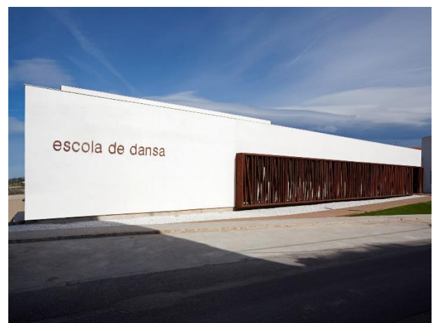
Fig. 4.3.2 Fachada exterior del conjunto (Diego Opazo, 2013)
