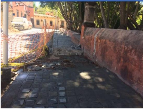
Construcción de banquetas.
