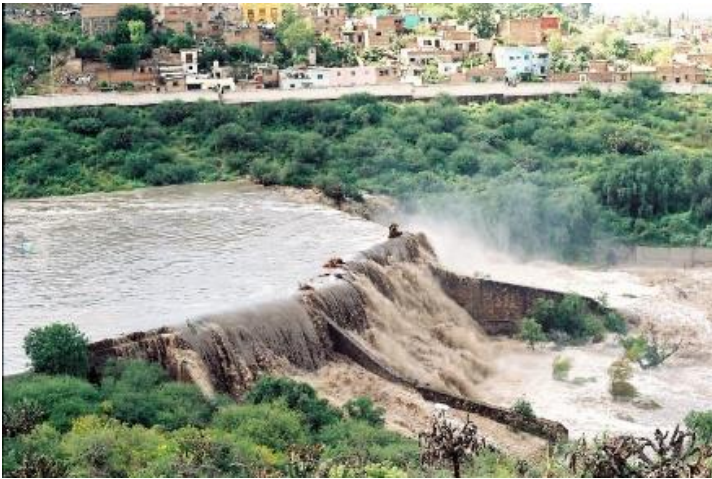
Desborde de la presa las colonias. Foto: José Ortiz Moya
