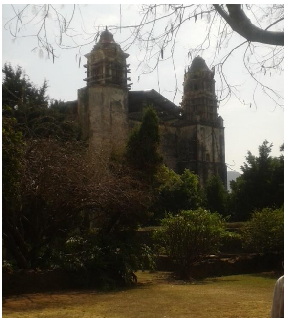
Trabajos de reparación de los campanarios del Ex Convento la Natividad
