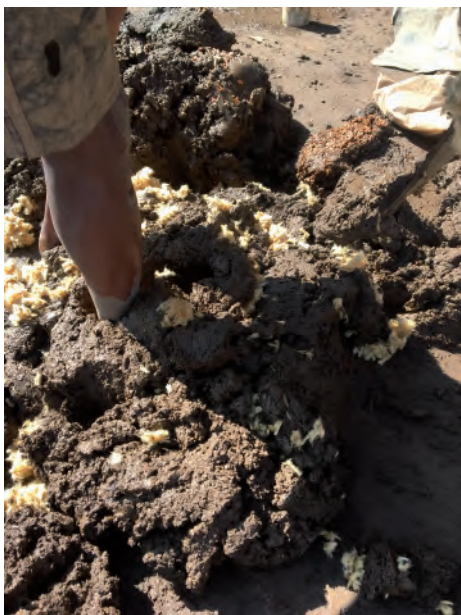
Figura 40. (Daniela Cruz Martínez, 2020) Elaboración de la mezcla con 1% de acetato de celulosa.
