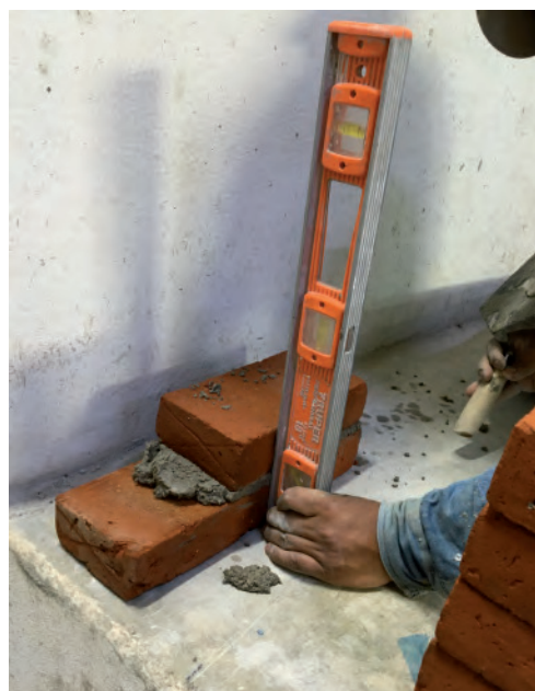
Figura 59. (Daniela Cruz Martínez, 2021) Verificación del junteo de las muestras a plomo con nivel.
