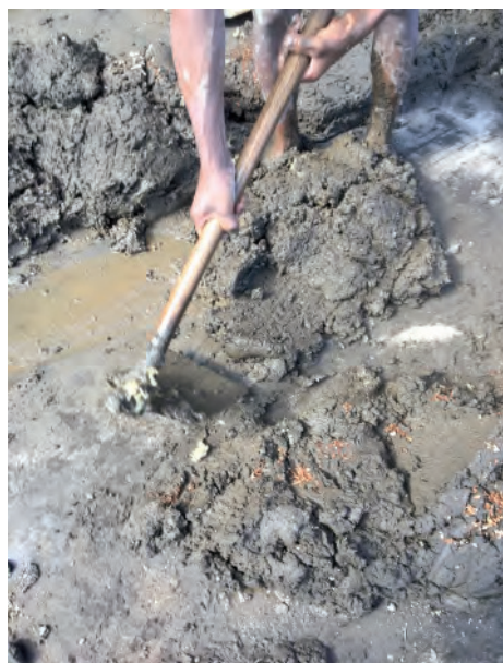
Figura 42. (Daniela Cruz Martínez, 2020) Mezcla con contenido del 1% de acetato de celulosa.
