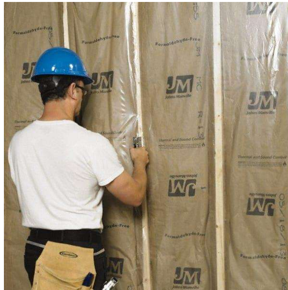
Figura 26 Trabajador instalando la película de plástico, tomada de la compañía MSC
