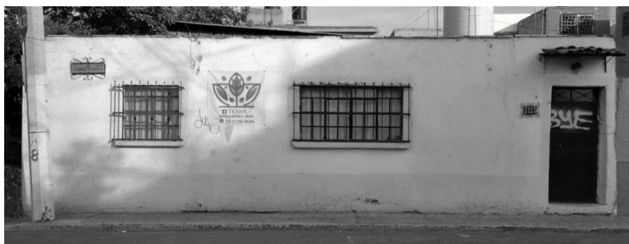
Figura 38 Inmueble 2 "TESSA". (Fotografía de E. Itzamntul Flores Torres.)
