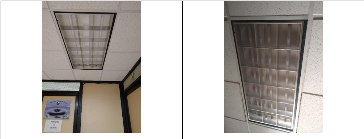
Figura 2. Luminario troffer parabólico de 120x60 cm, para 2 o 3 lámparas fluorescentes lineales FO32W/T8/841/ECO de 32W y temperatura de color 4100 K Fuente: Elaboración propia
