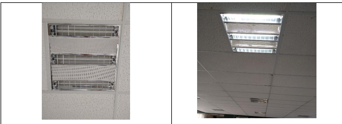
Figura 4. Luminario para empotrar de 60x60 cm, para 3 lámparas fluorescentes lineales TL5 Essential 14W/840 de 14W y temperatura de color 4000 K Fuente: Elaboración propia
