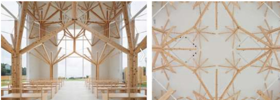
Fig. 96. ‘Técnica de auto similitud y de dimensiones diferentes en el elemento tectónico’. Fuente imagen 234
