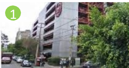
Estacionamiento del Hotel Sheraton
