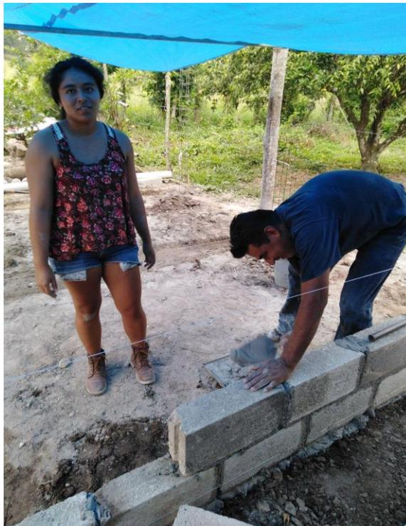
**Figura 3.3.6.** Fotografía del señor Salvador Díaz pegando los blocks para construir las paredes de los estanques.
