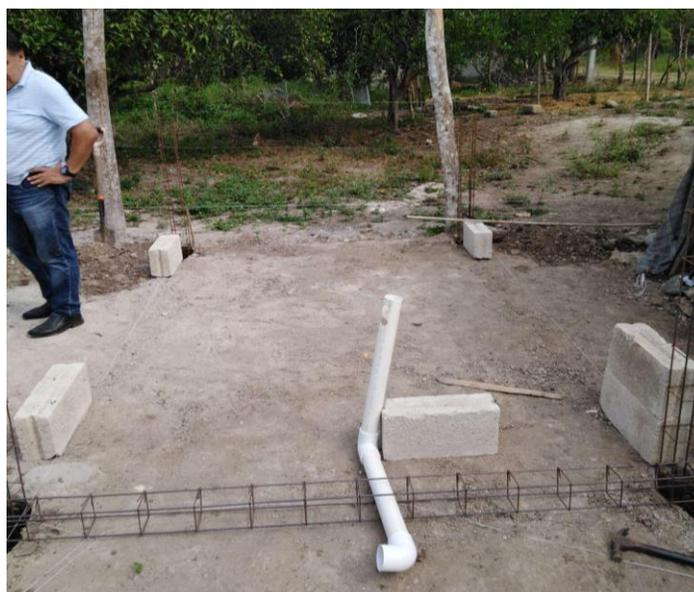
**Figura 3.3.5.** Fotografía de la construcción de los estanques, se muestra la instalación hidráulica de salida atravesando las cadenas del base perimetral previo a su relleno con cemento.
