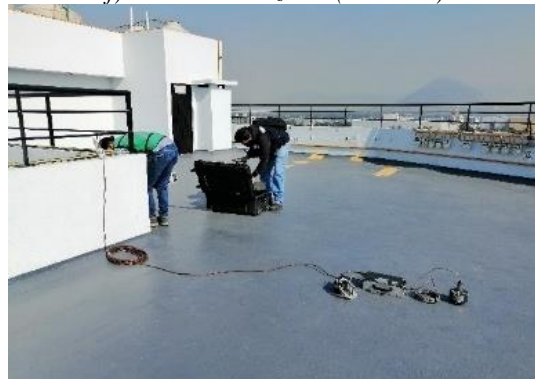
h) Posición 8. Azotea (centro)
