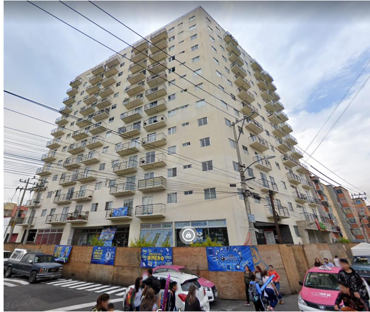
Figura 3.5. Edificio en estudio en su estado original, antes de la rehabilitación estructural (crédito: Google maps, 2019).
