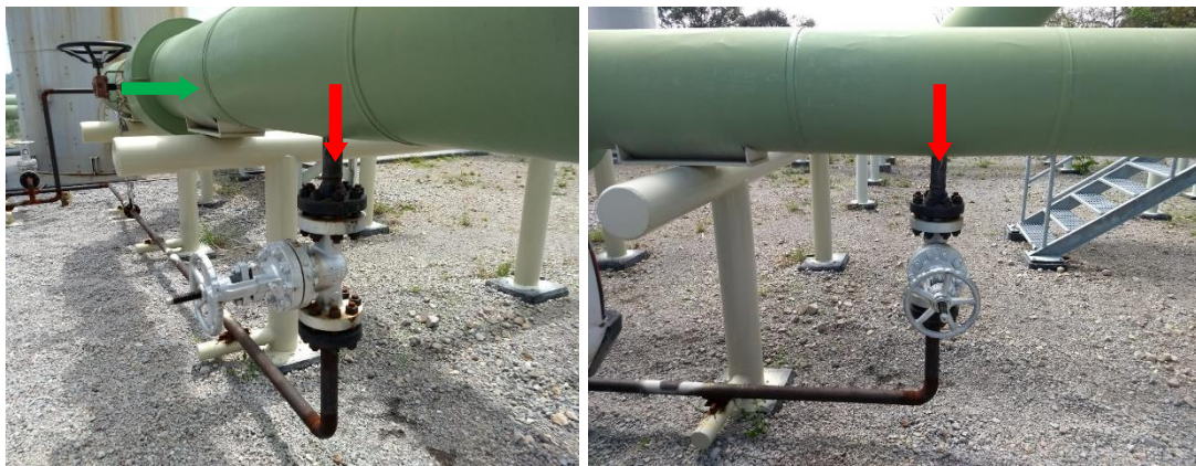
Fig. 11 A partir de una línea ya existente de vapor, se hizo una pequeña toma para alimentar al DGA 200
