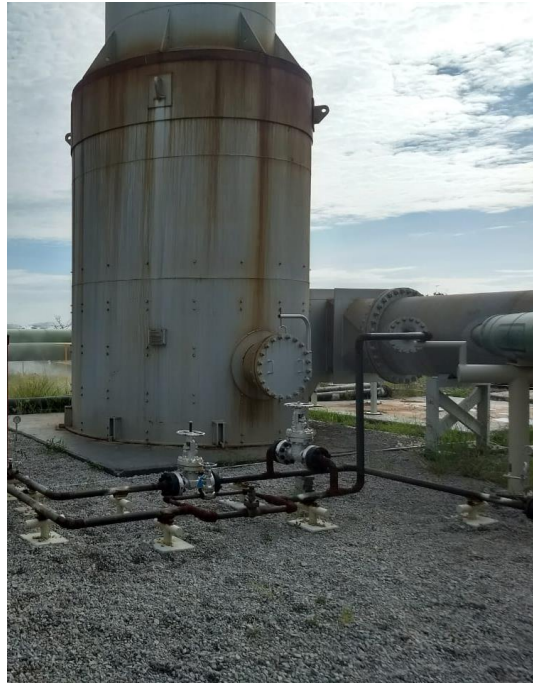
Fig. 10 Izquierda. - Línea de toma desde la PS02; línea hacia proceso (flechas rojas), y retorno del fluido geotérmico (flechas verdes). El sistema cuenta con un juego de diferentes válvulas que facilitan la regulación de los niveles del agua en la plataforma; Derecha. - Instalación real en sitio
