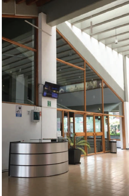
IMAGEN 28. Fotografía de vestíbulo principal del Centro Cultural y Social Veracruzano, Elaboración propia.
