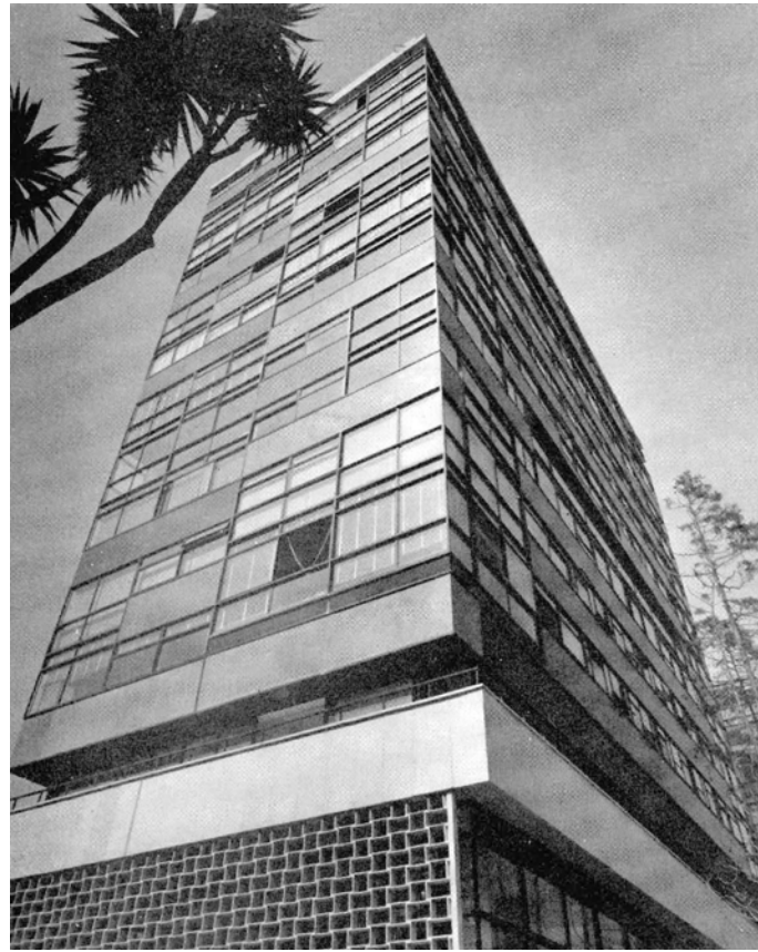
Imagen 60. Edificio con vista desde Paseo de la Reforma.
