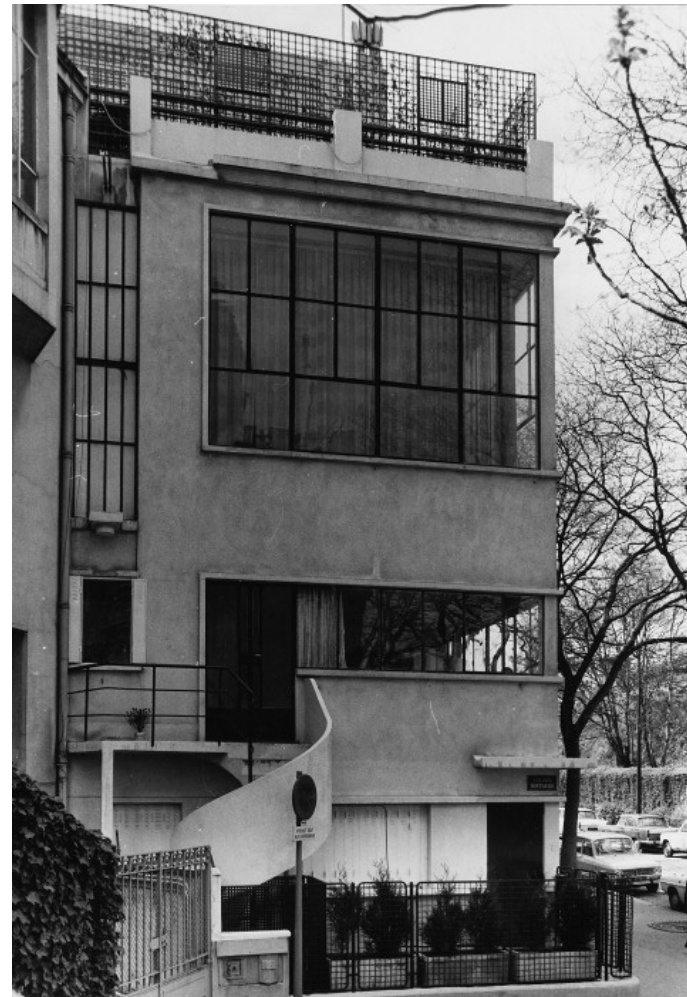
Imagen 7. Vista exterior de la Maison Ozenfant , Le Corbusier. París, 1922. Destaca el uso de la línea recta y la proporción de vano-macizo.
