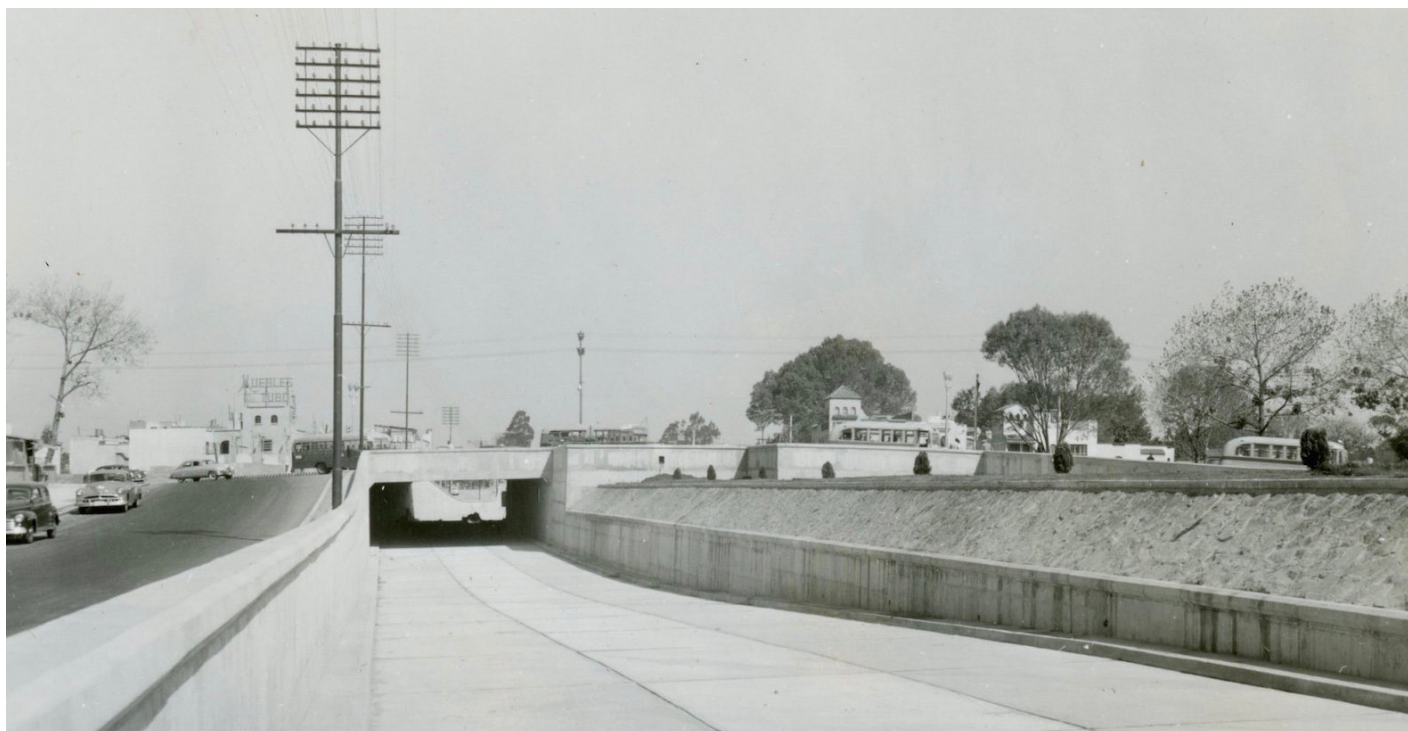
Imagen 13. El Viaducto y su cruce con las avenidas Insurgentes y División del Norte en 1950, poco antes de su inauguración. Destaca el bajo puente para la circulación ininterrumpida de los automóviles y el ecoducto al centro.
