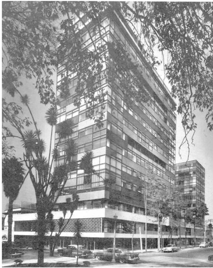
Imagen 59. Edificio con vista desde Paseo de la Reforma.
