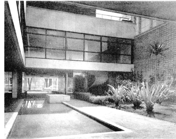
Imagen 65. Vista del patio interior entre edificios. Destaca la planta que conecta ambas torres.
