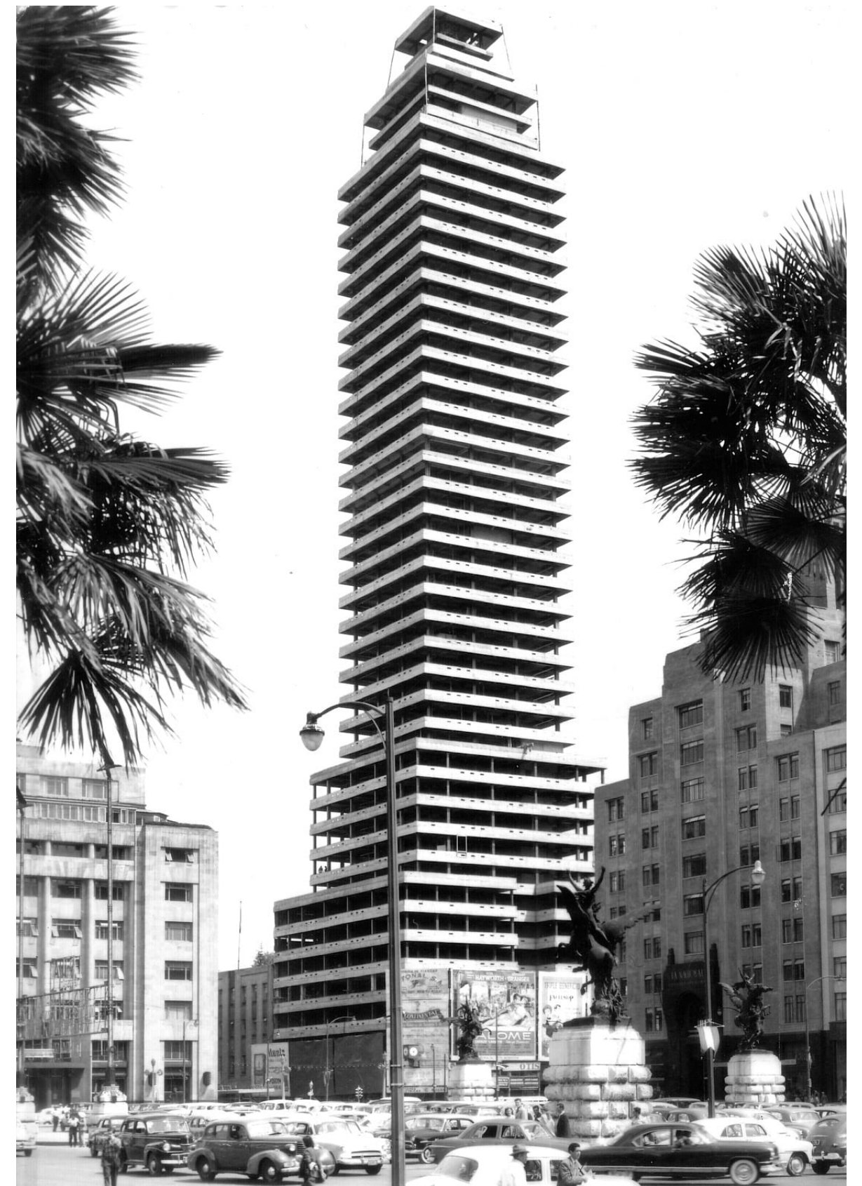
Imagen 14. La construcción de la Torre Latinoamericana cerca de 1953. Este edificio es obra de Augusto H. Álvarez, Leonardo y Adolfo Zeevaert, y fue inaugurado tres años más tarde. Destaca la super estructura de la Torre.
