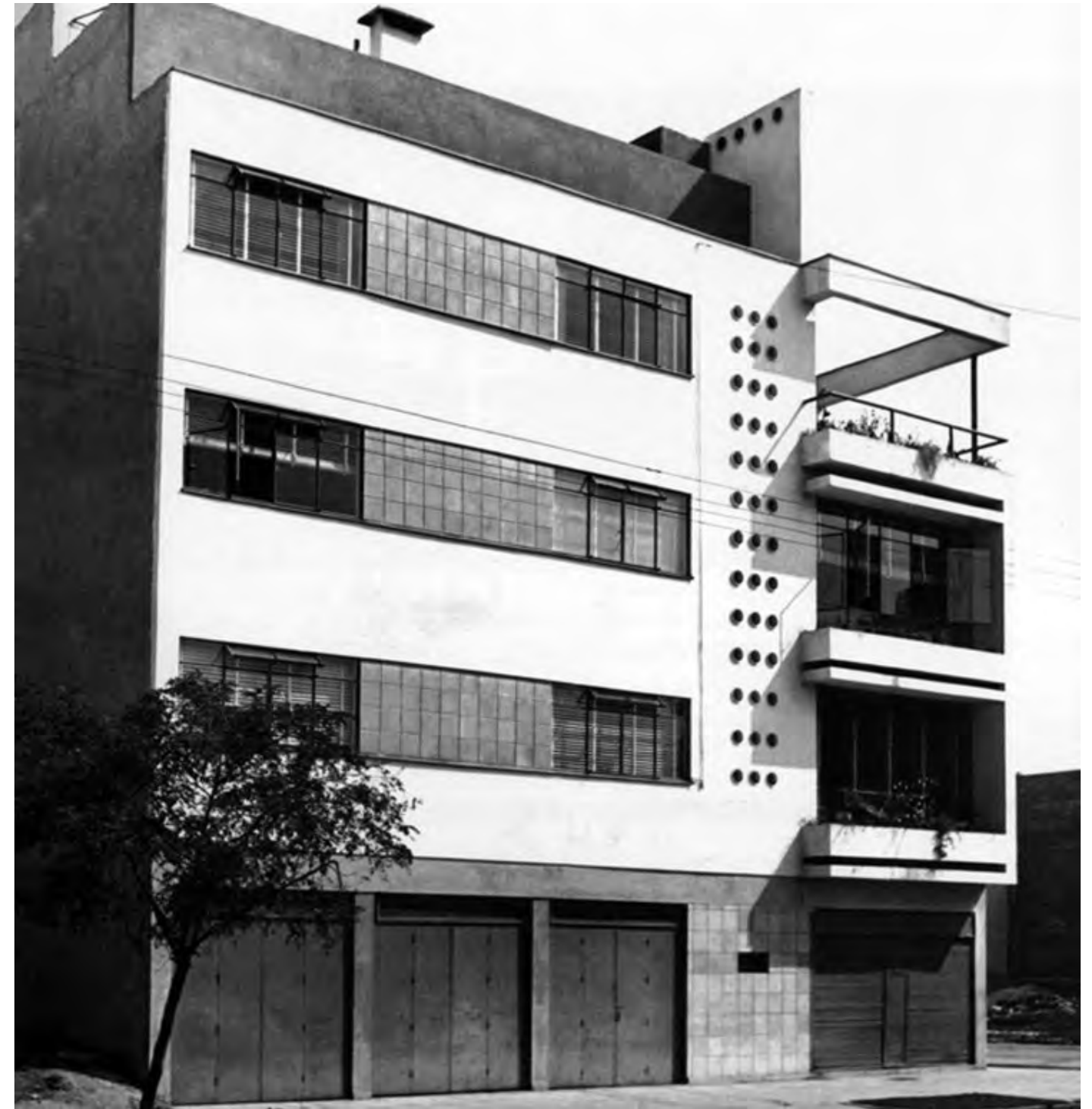
Imagen 24. Fachada sobre Río Pánuco. Destacan las ventanas horizontales, el remate y la materialidad del edificio.
