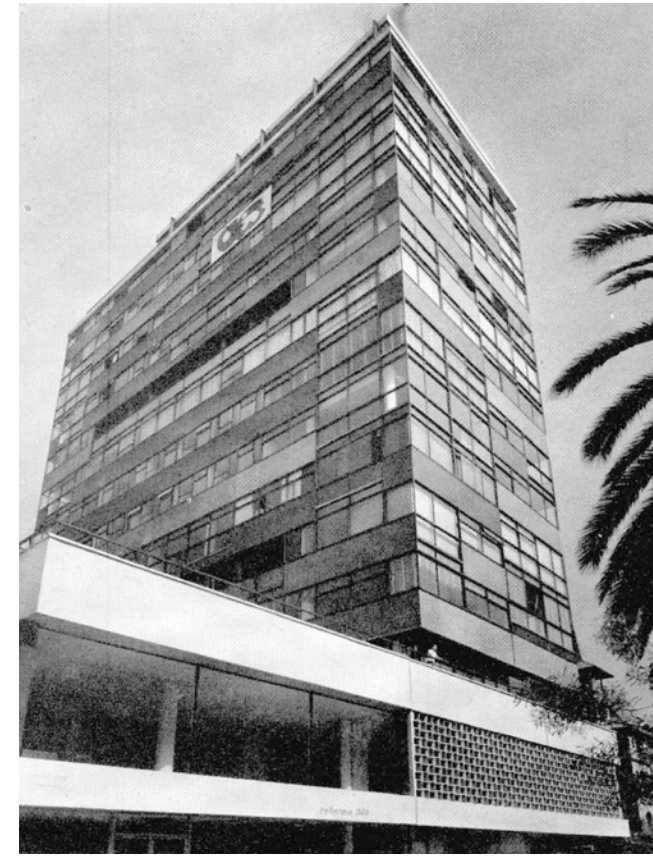
Imagen 61. Edificio con vista desde Paseo de la Reforma.
