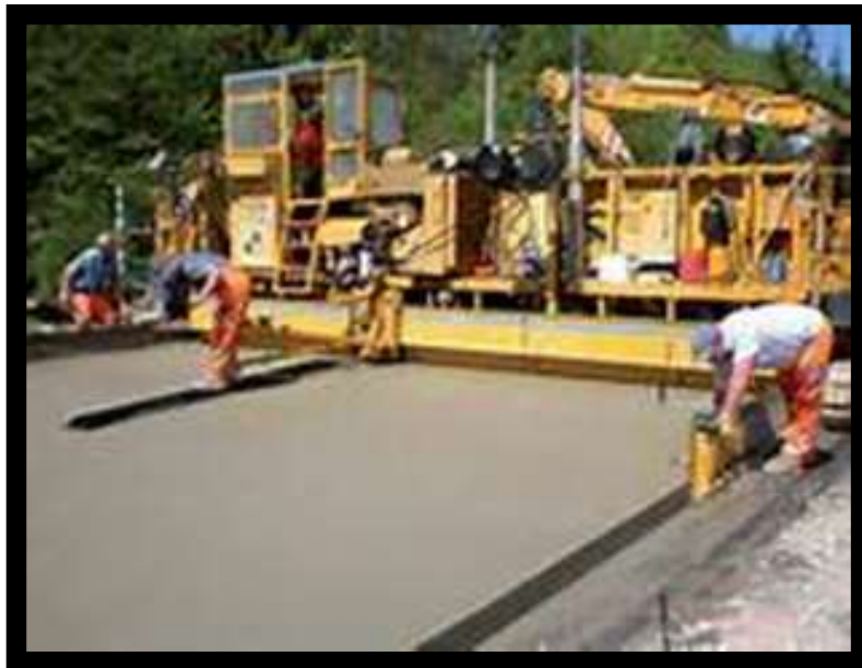
Fig.19.- Afine y texturizado de superficie colocada y compactada.
