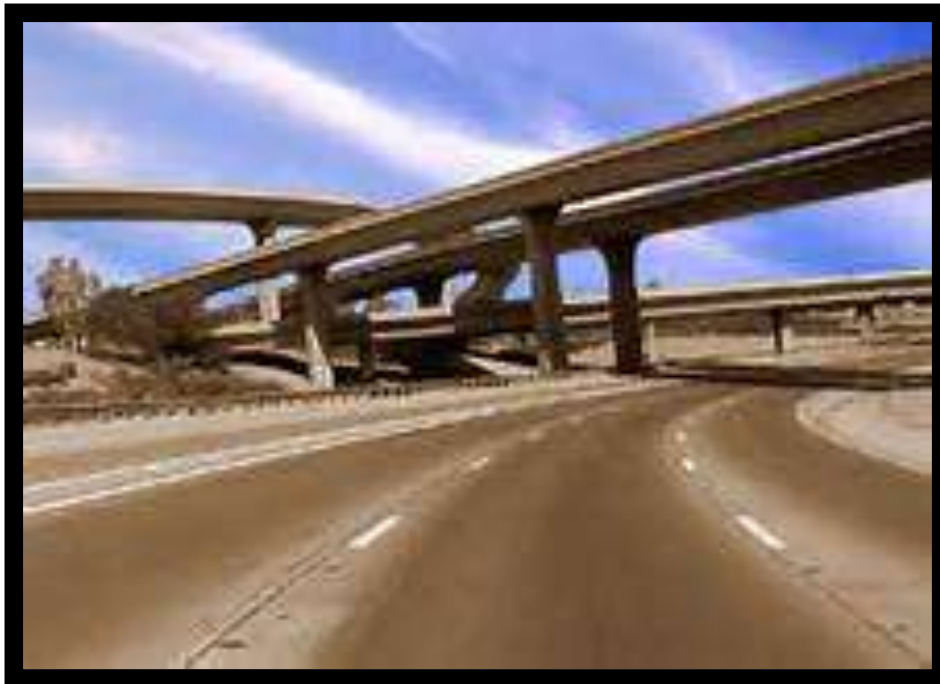
Fig. 1.- Tramo de Autopista de Concreto Hidráulico.
