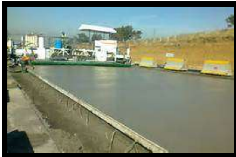
Fig. 21.- Concreto distribuido por la Pavimentadora.
