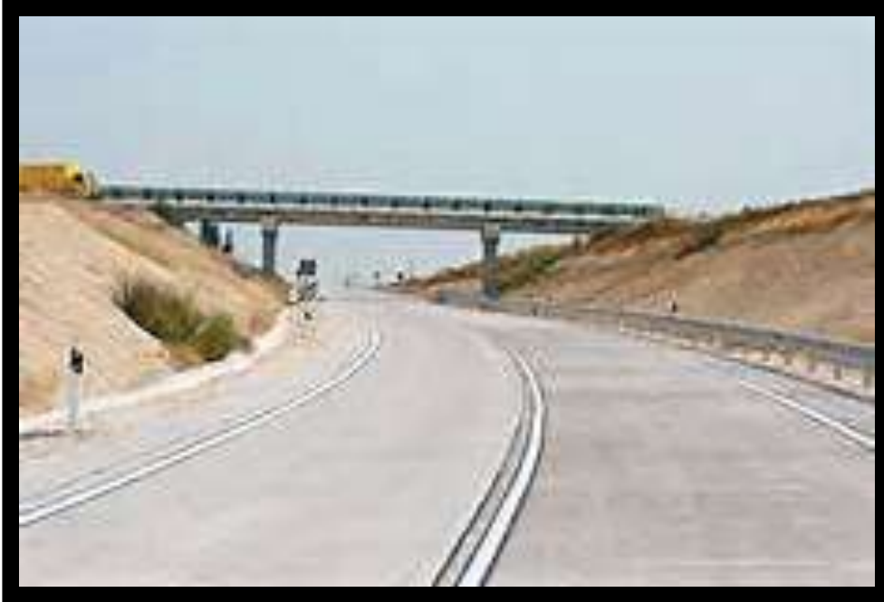
Fig. 2.- Construcción de Autopista de Concreto Hidráulico.
