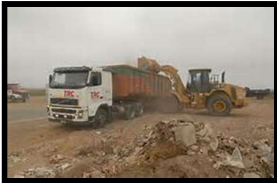
Fig.16.- Preparación de tramo y coordinación con el tendido de concreto.
