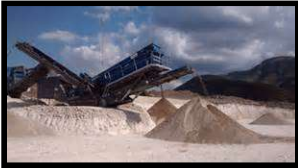
Fig. 7.- Planta Trituradora Productora de Arena.
