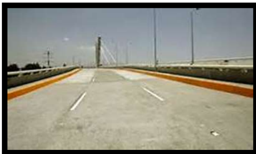
Fig.38.- Tramo totalmente terminado. .
