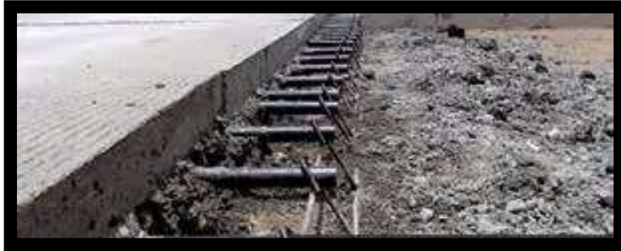
Fig. 27.- Junta preparada al final de la jornada de colado.
