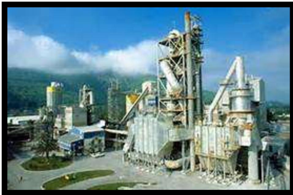
Fig. 10.- Planta Productora de Cemento.
