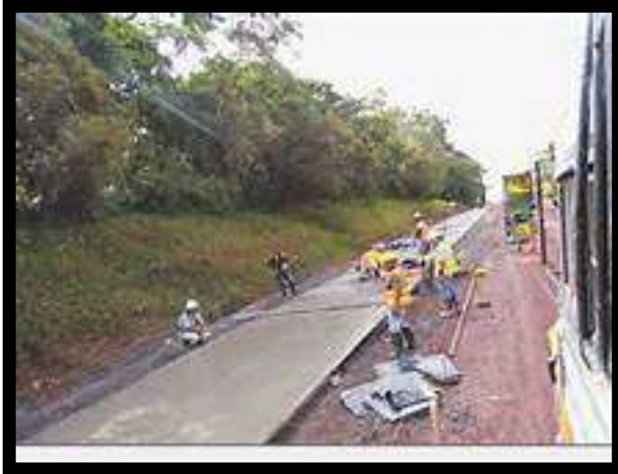
Fig. 31.- Medición de losa para realizar los cortes transversales.
