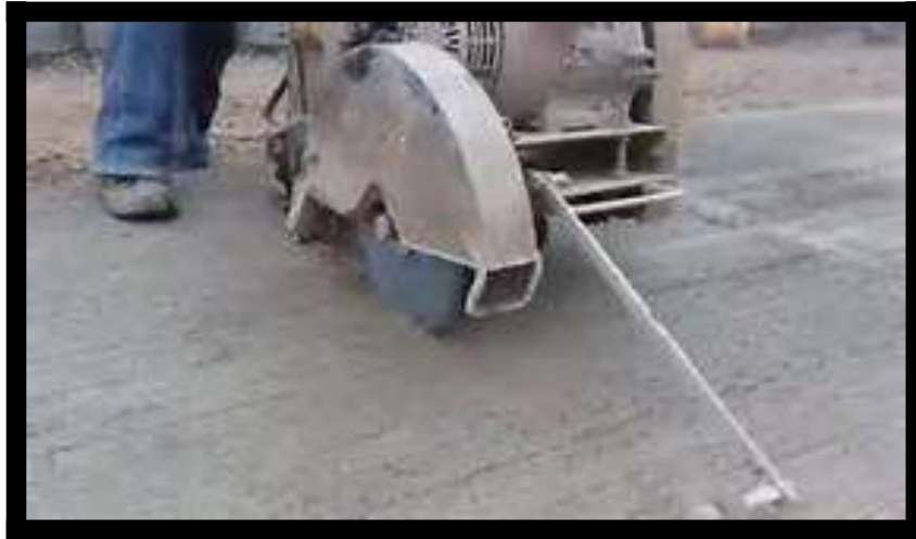
Fig. 35.- Corte Transversal realizado por disco de diamante.
