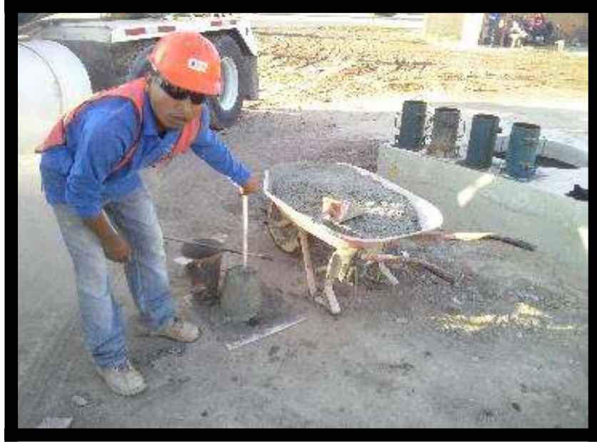
Fig. 4.- Obtención del Revenimiento del Concreto Fresco en Obra.
