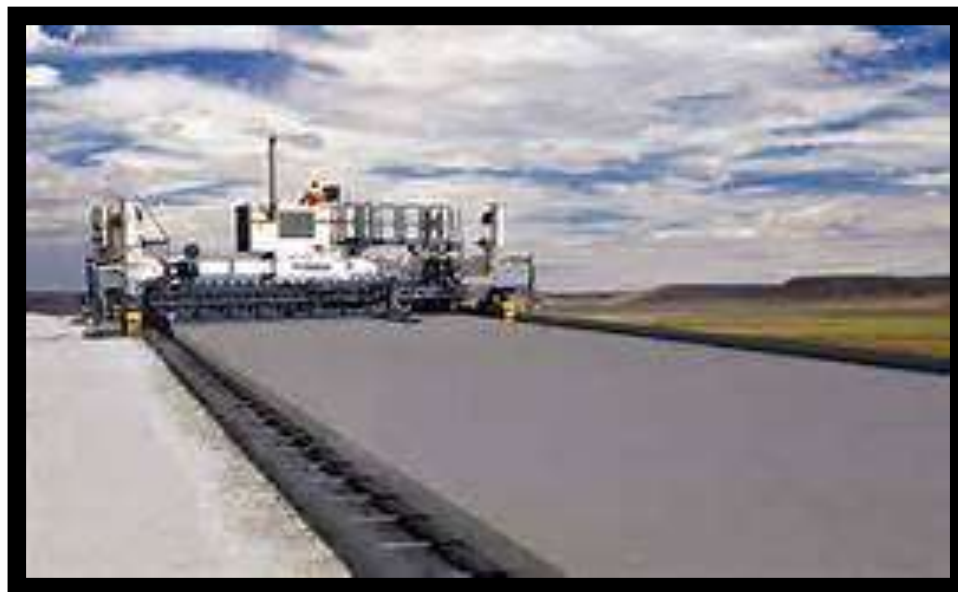
Fig.13.- Concreto transportado a obra y colocado por Pavimentadora.
