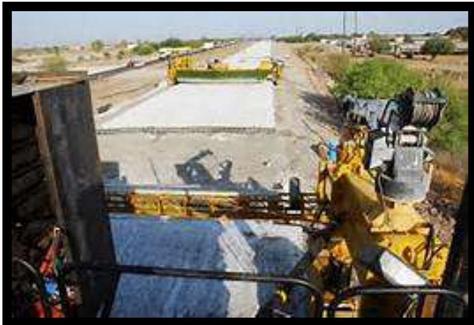
Fig. 28.- Junta provocada y maquina texturizadora.
