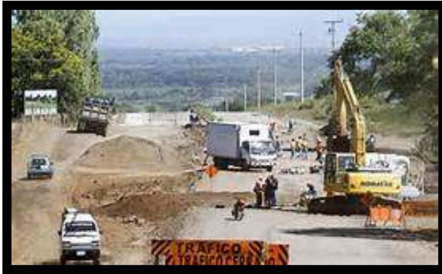
Fig.15.- Diversas actividades para preparación del tramo.
