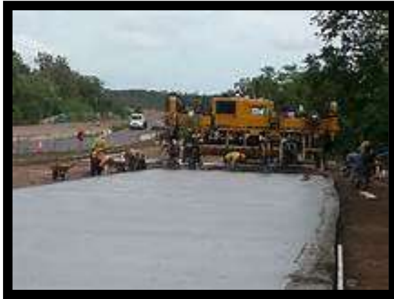
Fig.18.- Prueba de tendido de concreto en estado fresco.
