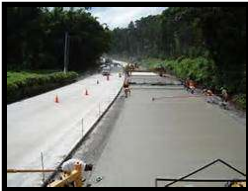
Fig. 30.- Afine de hombros de losa, plana y texturizado.
