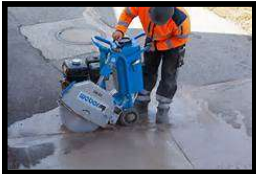
Fig. 34.- Equipo realizando corte de la Losa.
