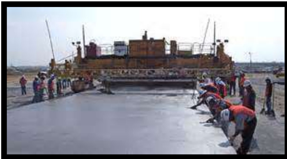
Fig.12.- Concreto colocado en tramo.
