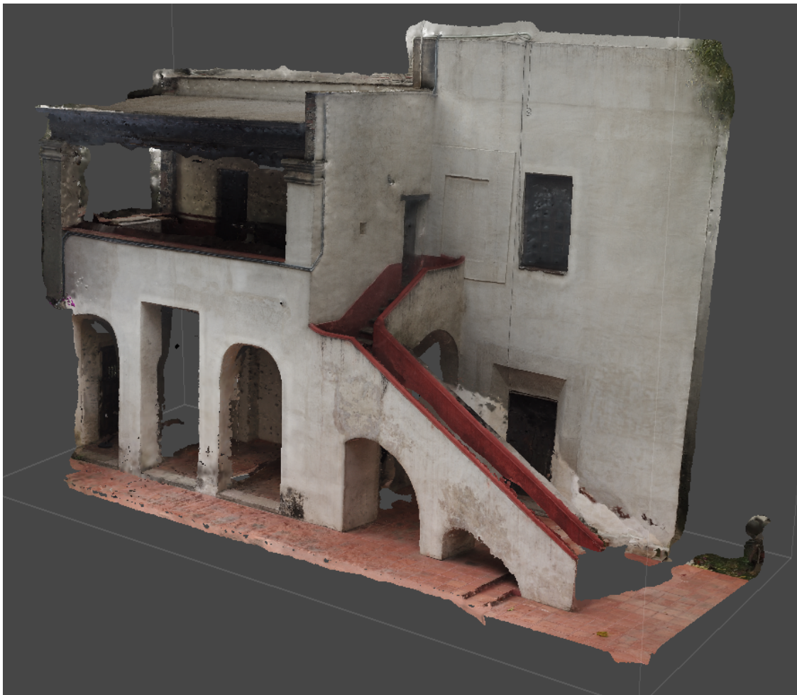
Ejemplo de levantamiento 3D realizado con dron y procesado mediante Agisoft Metashape.
