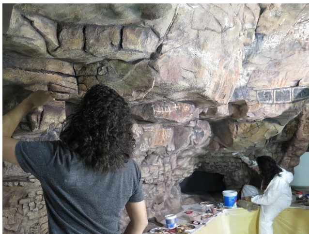
Aplicación de resane y acabados finales, Fotografía: S. Cruz, PNCPGR, CNCPC-INAH, 2018. Tomado de: Cruz, S., 2019, p. 43.
