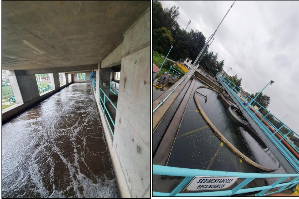
Sedimentador secundario
