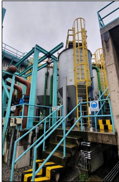
Desarenador visto de frente
