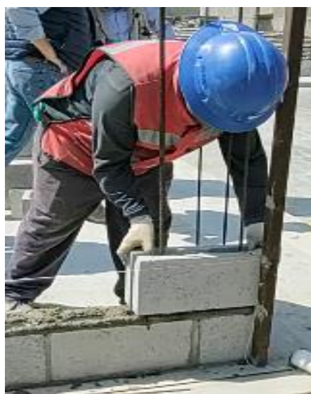
Ilustración 10.- Ejemplo de mortero para adherir mampostería. Fuente del autor
