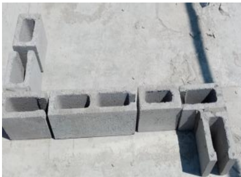
Ilustración 55. Primera hilada. Fuente del autor
