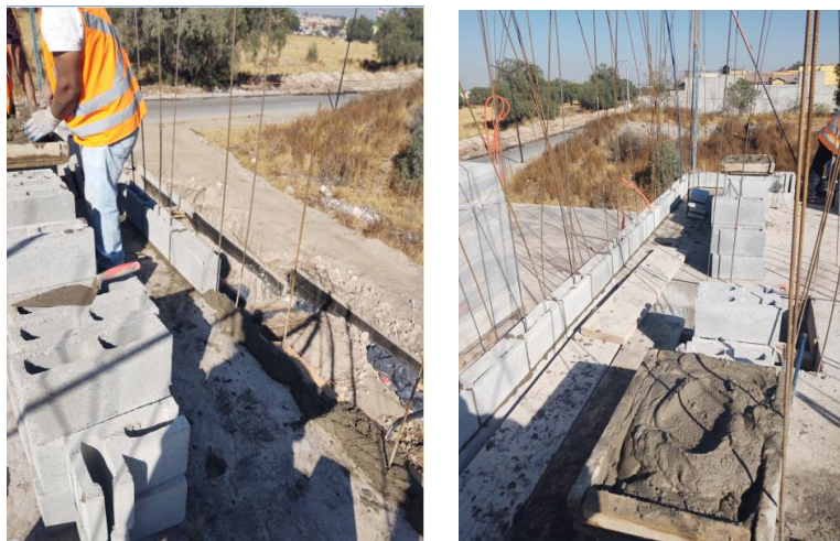
Ilustración 28. Ejemplo primer hilada. Fuente de autor
