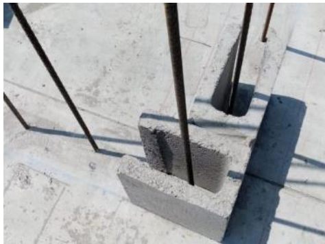
Ilustración 54. Colocación pieza esquinero. Fuente del autor
