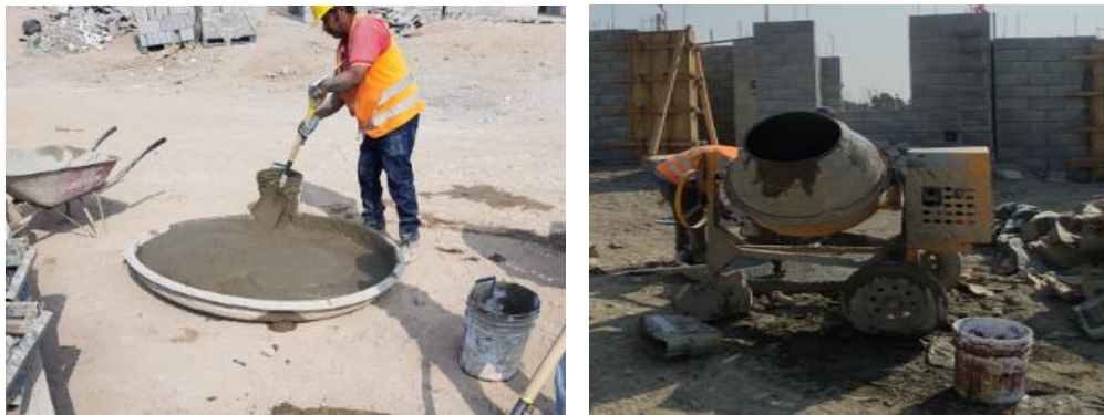
Ilustración 12.- Ejemplo de mortero hecho en obra mezclado manual y mecanizado. Fuente del autor
