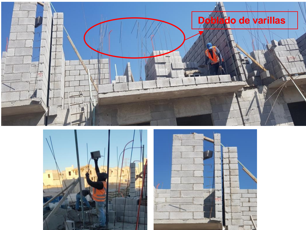
Ilustración 42. Ejemplo refuerzo vertical. Fuente del autor
