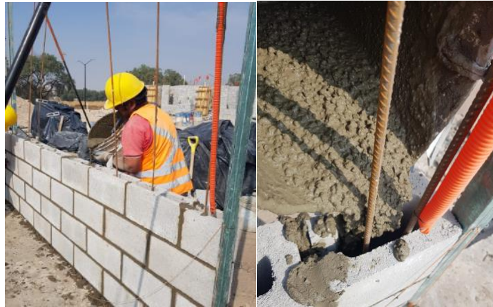
Ilustración 11.- Ejemplo de mortero de relleno. Fuente del autor
