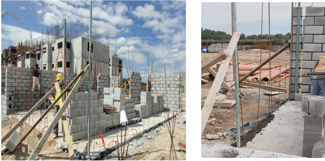
Ilustración 27. Ejemplo de colocación de reglas. Fuente de autor
