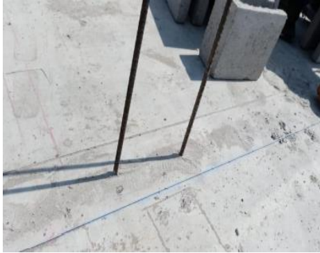
Ilustración 53. Trazo de ejes. Fuente del autor
