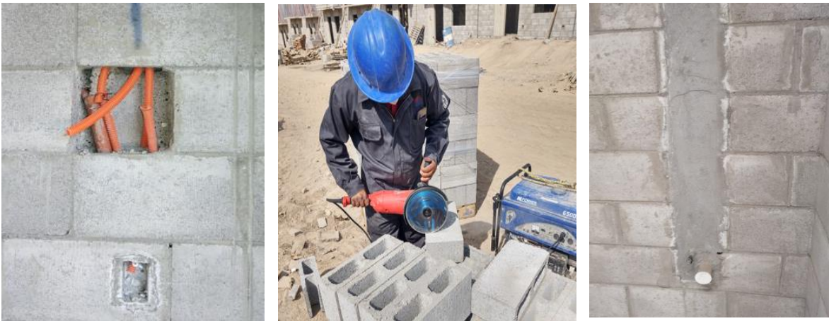
Ilustración 62. Instalaciones centradas y cortadas con disco de corte. Fuente del autor
