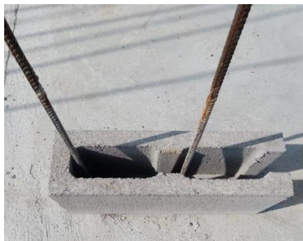
Ilustración 57. Pieza open end C con acero vertical junto. Fuente del autor
