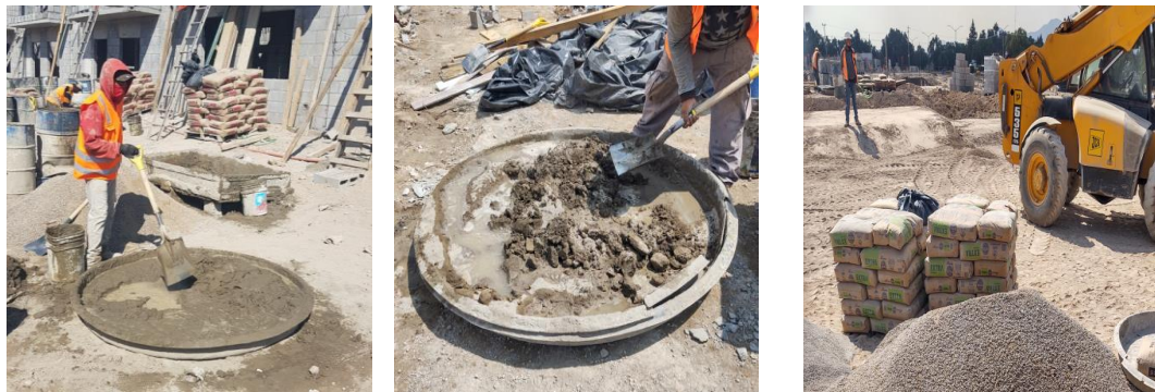
Ilustración 39. Ejemplo de mezcla en obra. Fuente del autor
