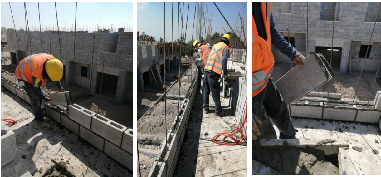
Ilustración 32. Colocación y pegado de piezas huecas. Fuente de autor
