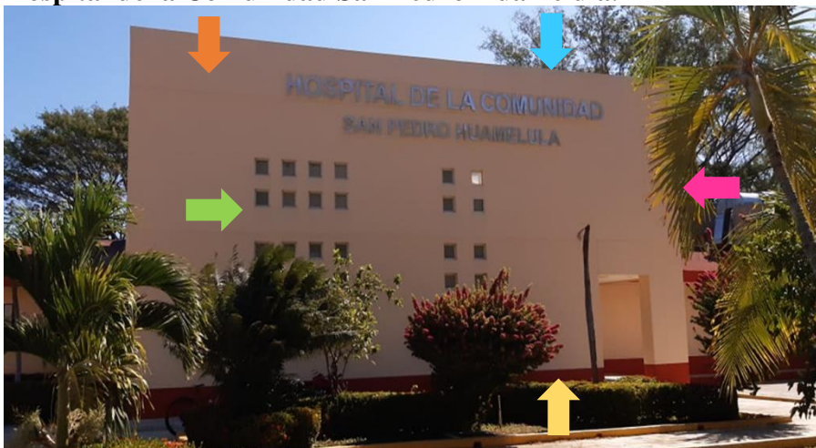
Ilustración 27. Hospital San Pedro Huamelula. Tomada de imágenes de Google, 2021.
