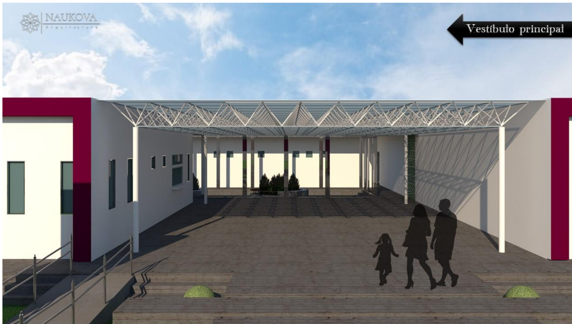
Ilustración 177. Vista del vestíbulo principal cubierta con tridilosa. (Loretto, 2021).
