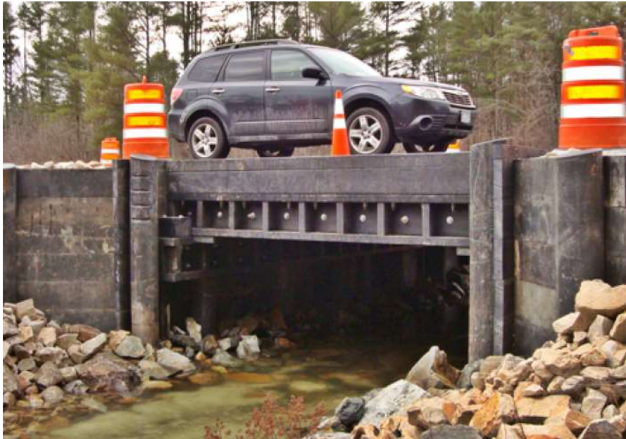
Figura 17. Primer puente de termoplásticos reciclados.
