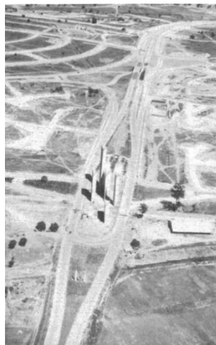
Fig. 123 Construcción de las Torres de Satélite, Naucalpan de Juárez, México. Revista Arquitectura México, No. 60.
