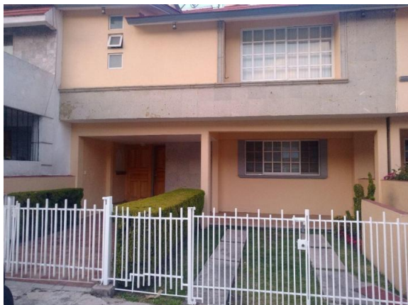
Fig. 178 Rejas, protecciones y cortinas para el aislamiento y para salvaguardar la seguridad en la Alteña I. Fuente: Inmuebles24.
