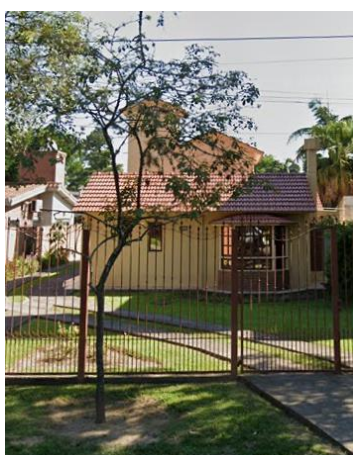
Fig. 94 Chalet suburbano en Av. Mate de Luna, Tucumán, con ventana mirador. Fuente: Street View de Google Maps.
