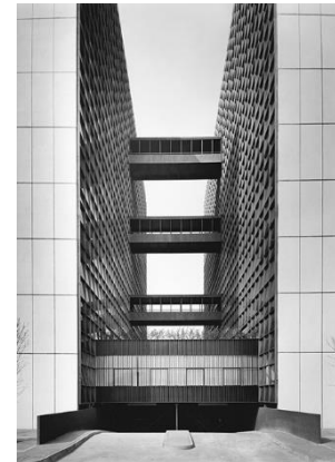
Fig. 51 Vista de las dos torres conectadas por los puentes de liga, Palacio de Justicia, Doctores, Ciudad de México, 1964. Fuente: Archivo Histórico Sordo Madaleno, fotografía de Guillermo Zamora.
