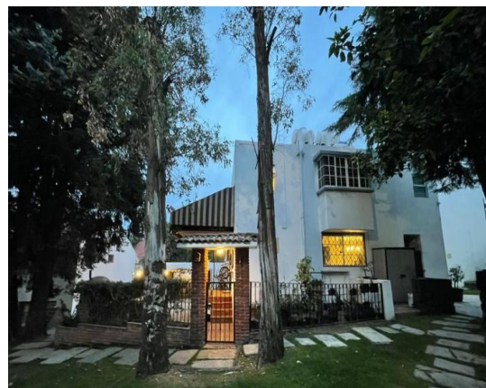
Fig. 179 Rejas y protecciones para el aislamiento y para salvaguardar la seguridad en la Alteña I. Fuente: Inmuebles24.
