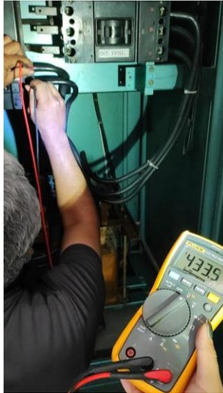
8.4.- Por último, se tomaron las mediciones de corriente de la fase 1 ( $X_1$ ), la fase 2 ( $X_2$ ) y la fase 3 ( $X_3$ ) del transformador con el uso del amperímetro de gancho. Para lo cual se posicionó el selector de función en  $\tilde{A}$  y se apretó el gatillo para abrir y cerrar la pinza.
