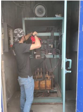
4.4.- Con el cabezal de una escoba y una brocha se removió la mayor cantidad posible de polvo que se encontraba en las bobinas y terminales del transformador, así como en los interruptores.
